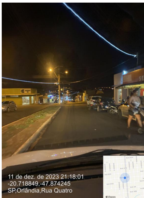
25 - Trecho de mangueira apagado no trecho da Rua 04 (Item 28)
