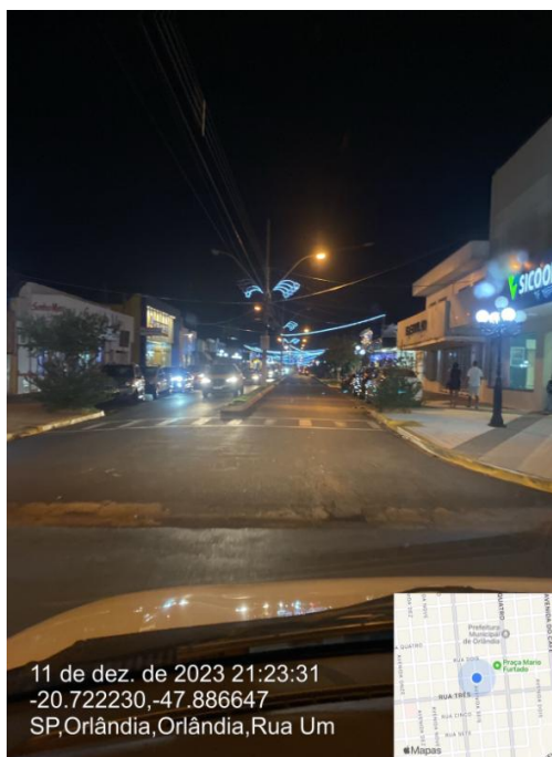
41 – Arabesco e mangueira apagados no trecho da Rua 1 (Item 25)
