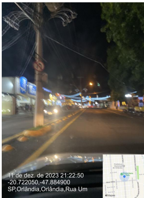
32 – Arabesco e mangueira apagados no trecho da Rua 1 (Item 25)
