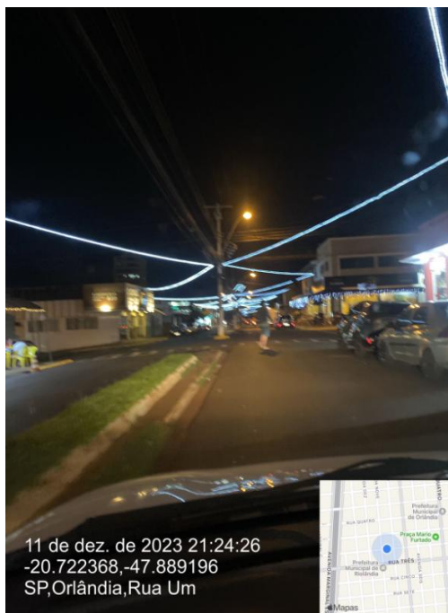
44 – Arabesco e mangueira apagados no trecho da Rua 1 (Item 25)
