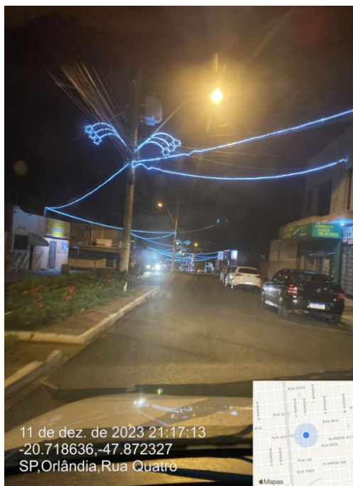
20 – Trecho de mangueira apagado no trecho da Rua 04 (Item 28)
