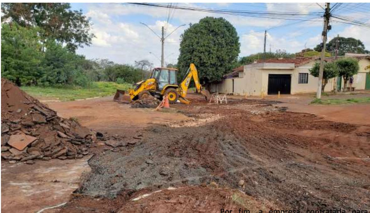
Por fim, a empresa contratada para operação tapa-buracos, fará a aplicação de uma camada de brita e pintura de ligação, que é o que garantirá a aderência da massa asfáltica, para ser então aplicada na área recortada, compactada e nivelada, resultando em uma superfície uniforme.
