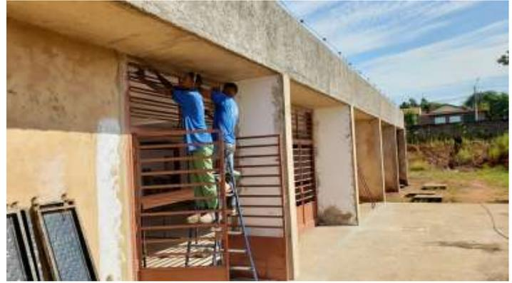
Assim está sendo realizado, desde o final de 2022, com a obra avançando de forma progressiva, chegando neste momento em 80%, com a execução de pintura das ferragens, instalação de pisos, revestimentos e toda parte hidráulica e elétrica.
