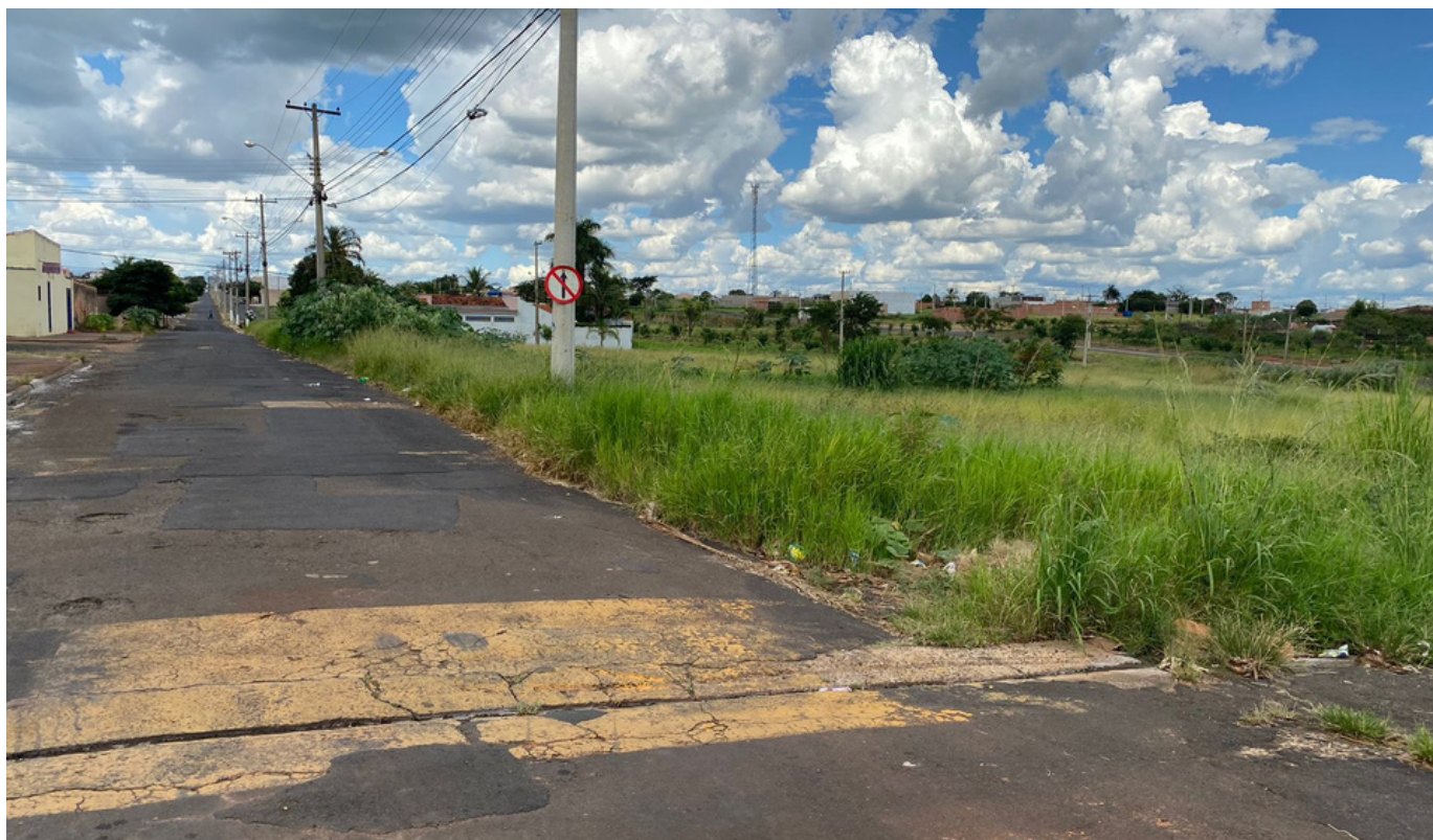
RUA 12, ENTRE AVENIDA O e AVENIDA P.
