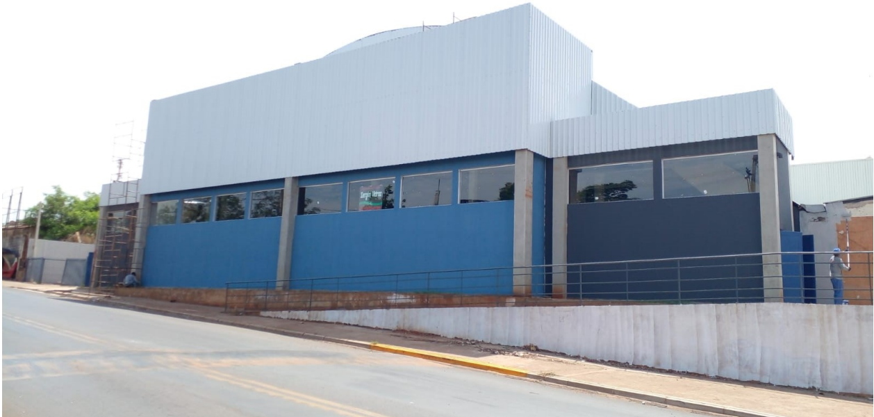
IMG 01 – Fachada principal do Ginásio. Externo.
