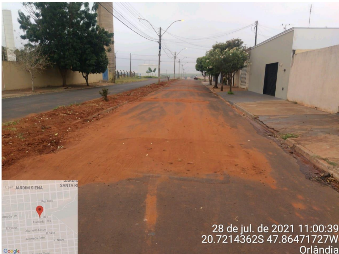
Figura 4 - RUA 03, ENTRE AVENIDA P E AVENIDA Q
