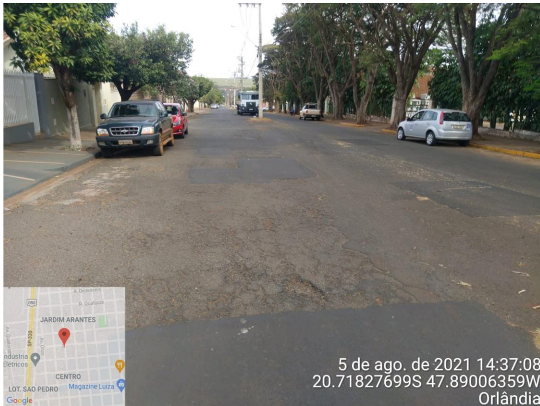
Figura 1 - AVENIDA 9, ENTRE RUA 06 E RUA 08
