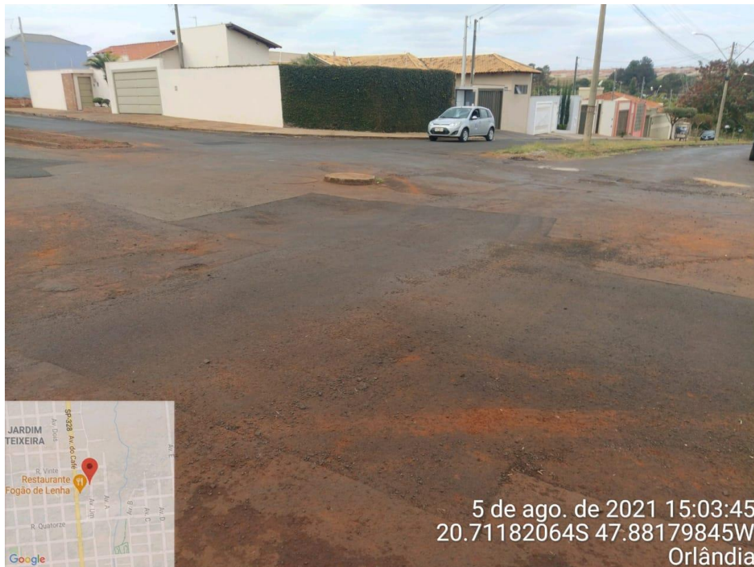
Figura 5 - BALÃO DA RUA 18 COM AVENIDA 1
