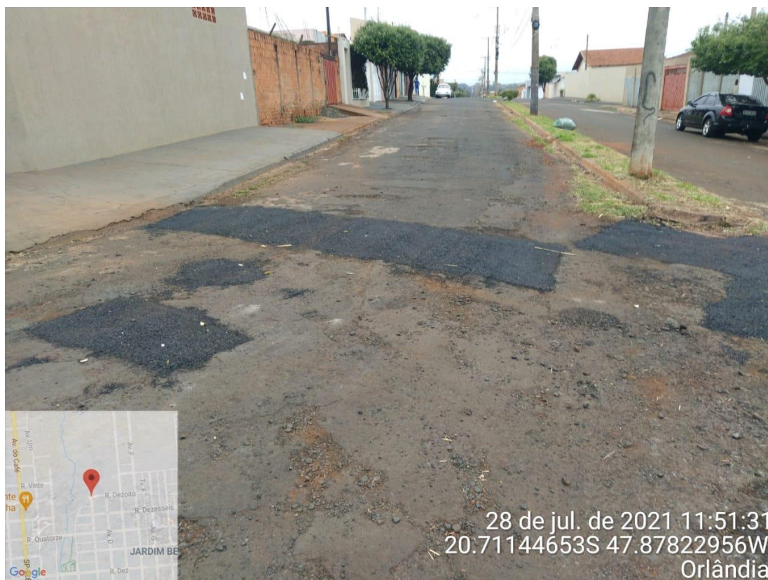
Figura 8 - AVENIDA C, ENTRE RUA 16 E RUA 18
