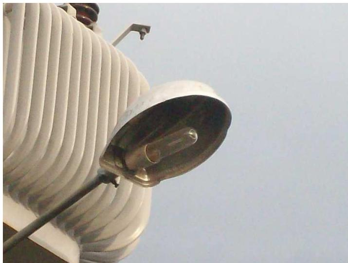
Figura 13 – Luminária inadequada para utilização em iluminação pública.
