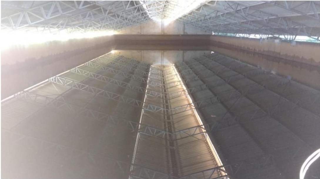
Figura 39 - Reservatório R5 - CR ETA
