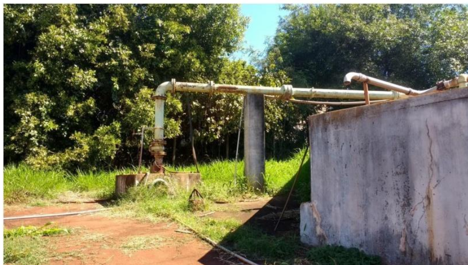
Figura 15 - Poço P1 e P5
