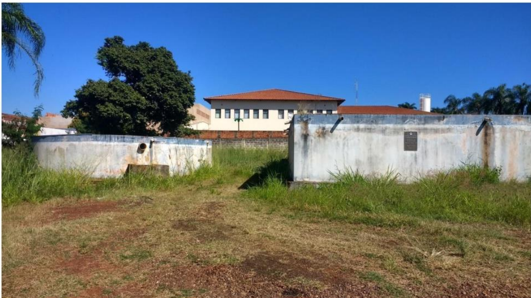
Figura 40 - Reservatórios CR ETA
