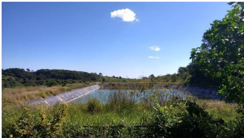
Figura 59 - Lagoa Anaeróbia ETE Orândia
