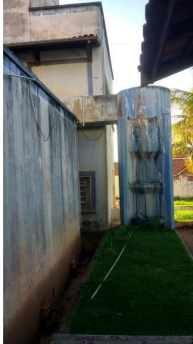
Figura 23 - Vista externa da estrutura de chegada de Água na ETA
