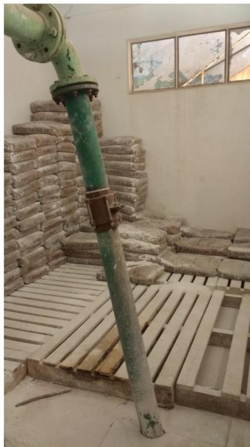
Figura 21 - Local de armazenamento de cal em pó - ETA
