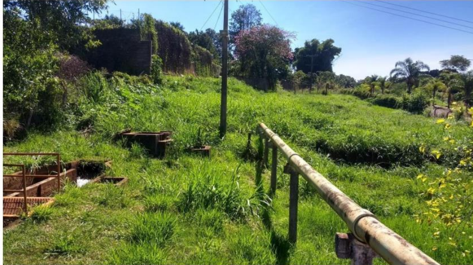
Figura 16 – Situação atual do Poço P1 e P5
