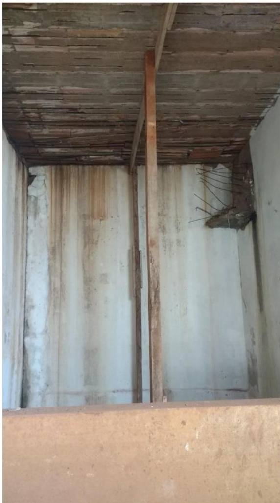
Figura 31 – Escoramento provisório de laje edifício ETA
