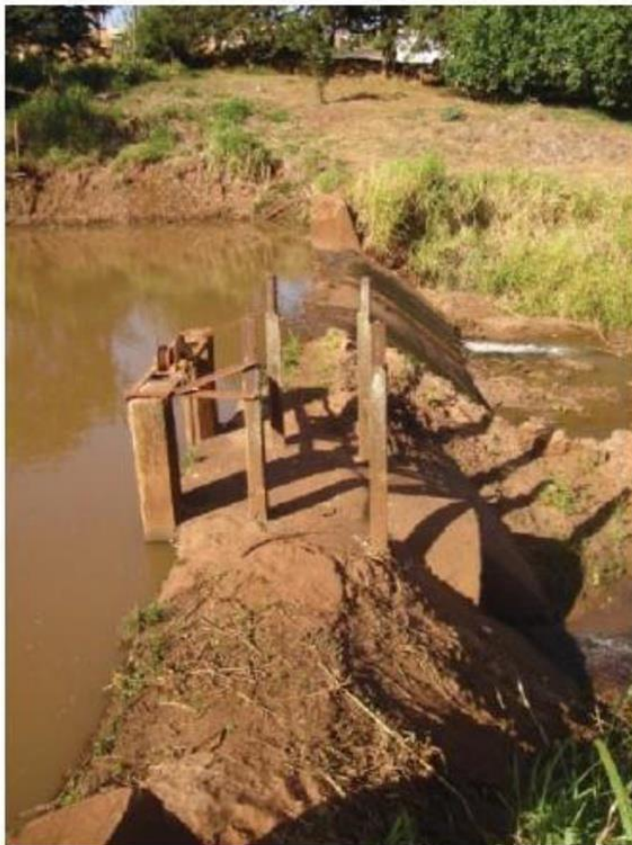
Figura 10 - Barramento para captação de água bruta Córrego dos Palmitos
