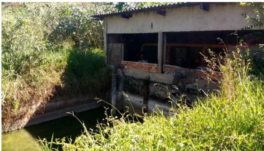
Figura 57 - Poço de Sucção da Estação Elevatória de Esgotos de Orândia
