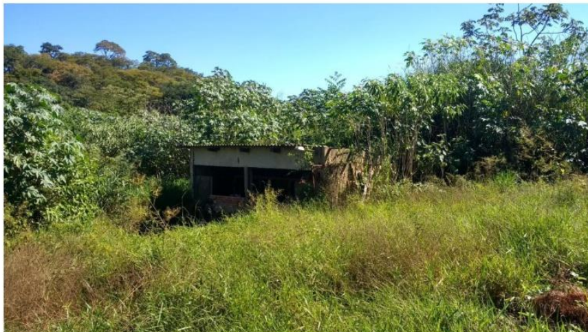
Figura 56 - Vista Geral da Estação Elevatória de Esgotos de Orândia
