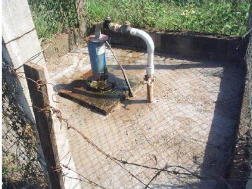
Figura 38 – Poço P10 – Capão do Meio
