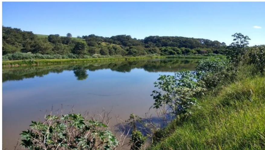
Figura 60 – Lagoa Facultativa ETE Orlandia
