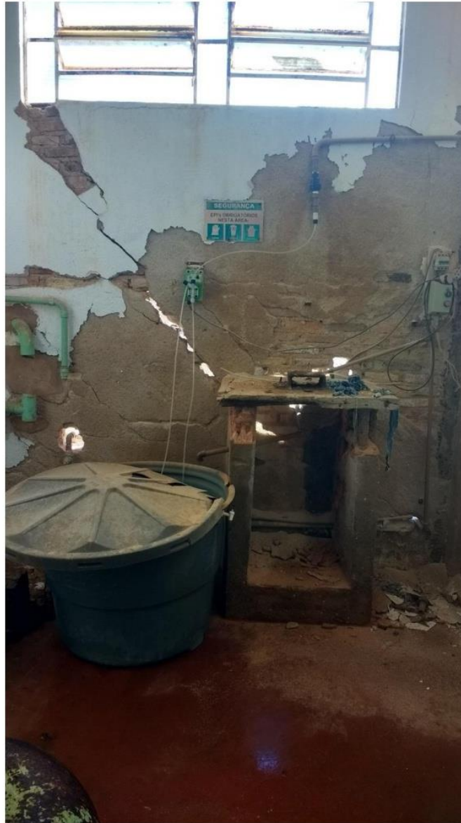
Figura 32 – Sistema de Dosagem de Hipoclorito de Sódio ETA
