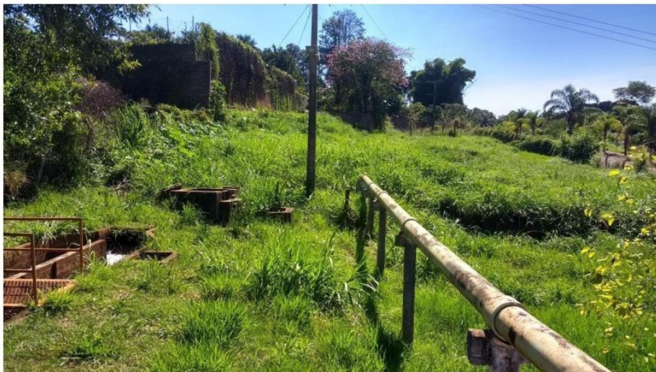
Figura 16 – Situação atual do Poço P1 e P5
