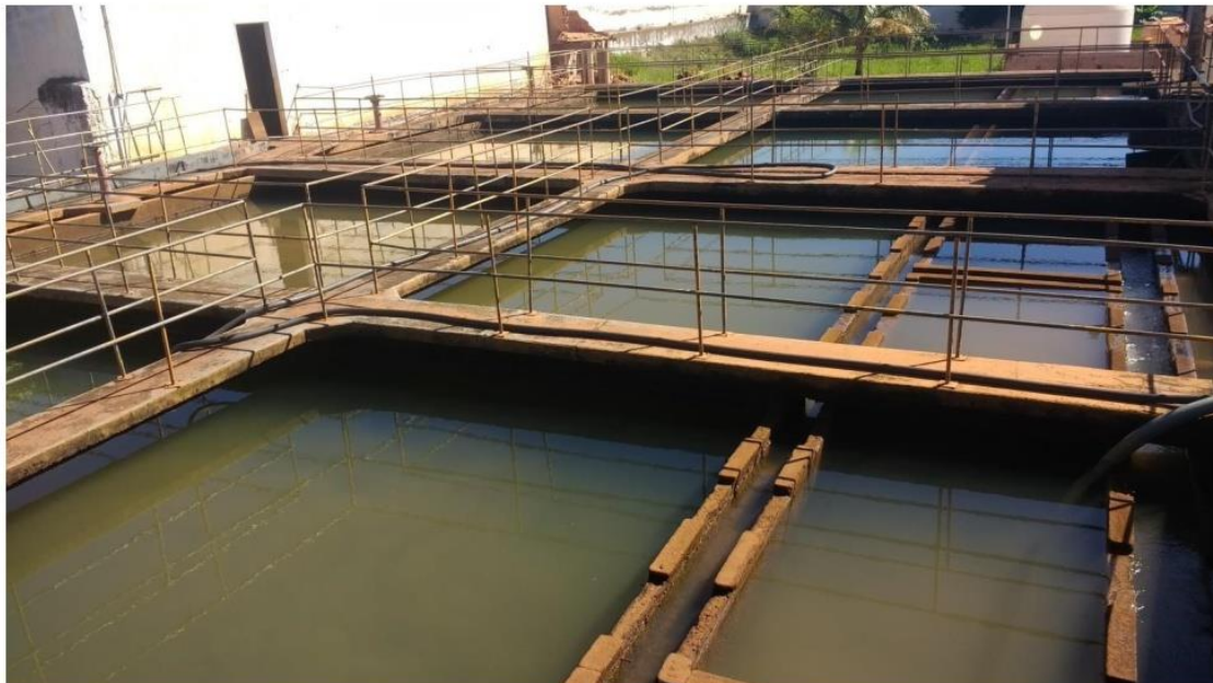
Figura 27 – Vista Geral dos decantadores, sendo duas unidades operando afogados
