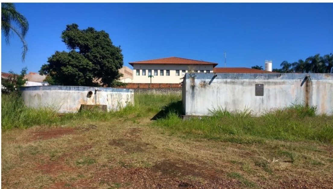
Figura 40 – Reservatórios CR ETA
