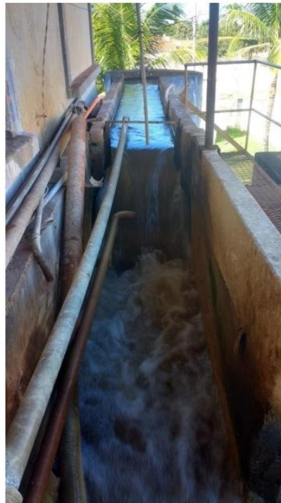
Figura 24 – Dispositivo de mistura rápida - ETA
