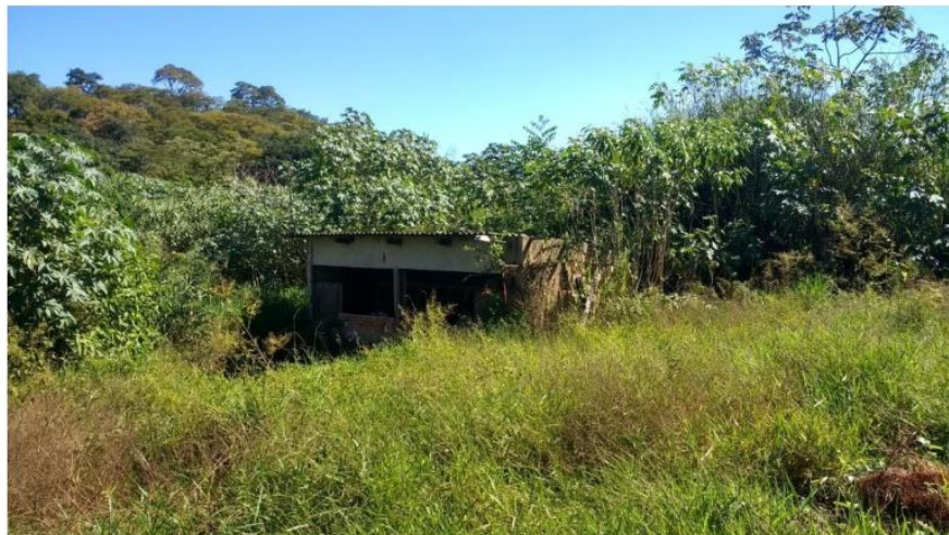
Figura 56 – Vista Geral da Estação Elevatória de Esgotos de Orlandia
