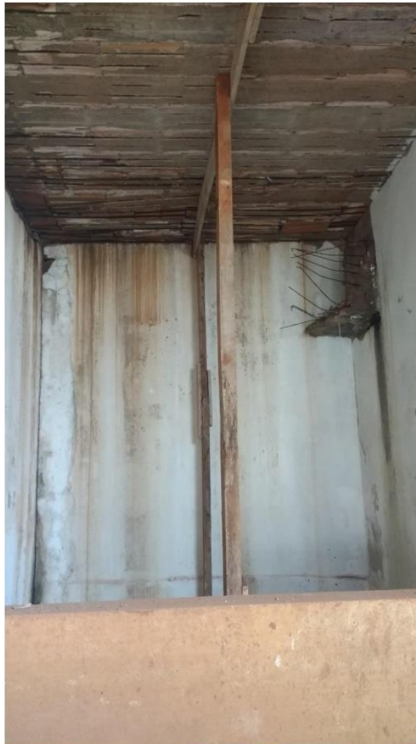
Figura 31 – Escoramento provisório de laje edifício ETA
