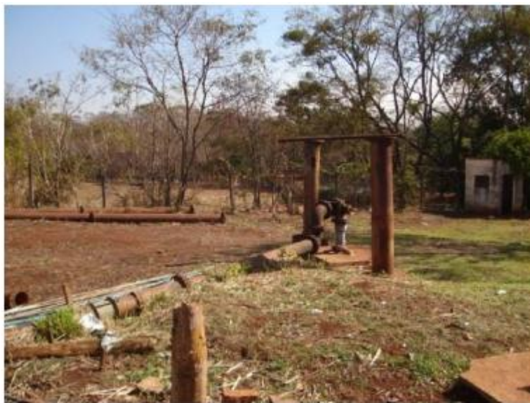
Figura 14 – Poço P3 - Gruta
