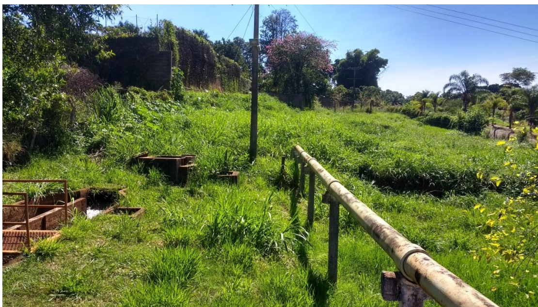
Figura 16 – Situação atual do Poço P1 e P5
