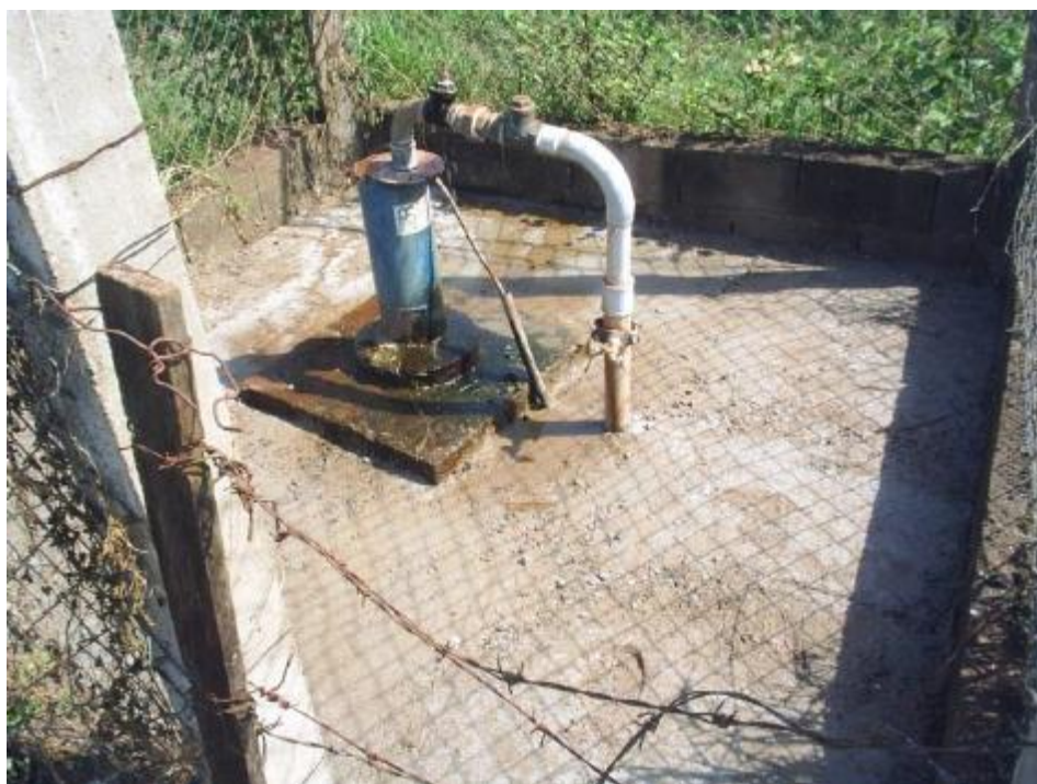
Figura 38 – Poço P10 – Capão do Meio
