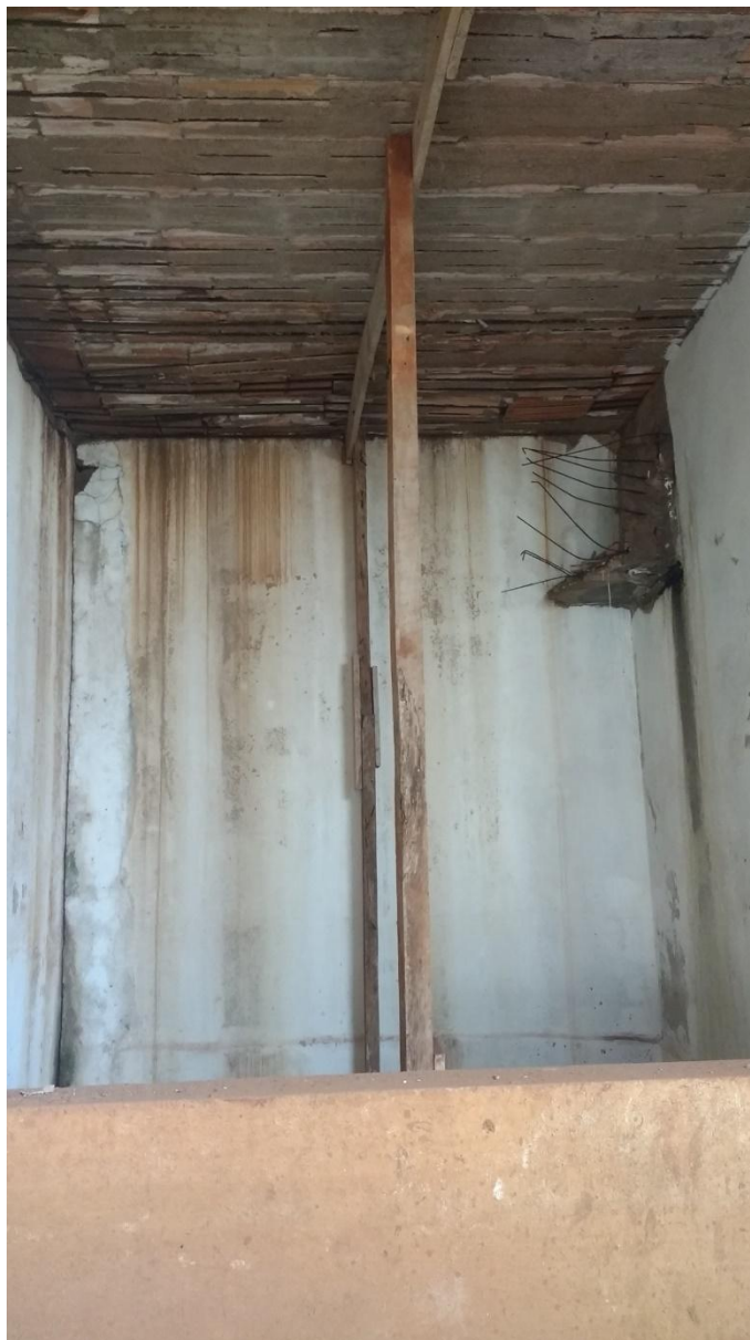
Figura 31 - Escoramento provisório de laje edifício ETA
