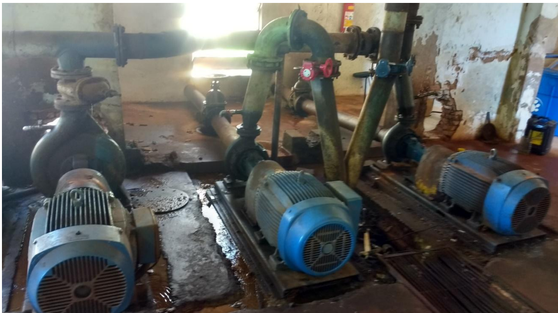
Figura 42 – Conjuntos Motobomba EEAT1
