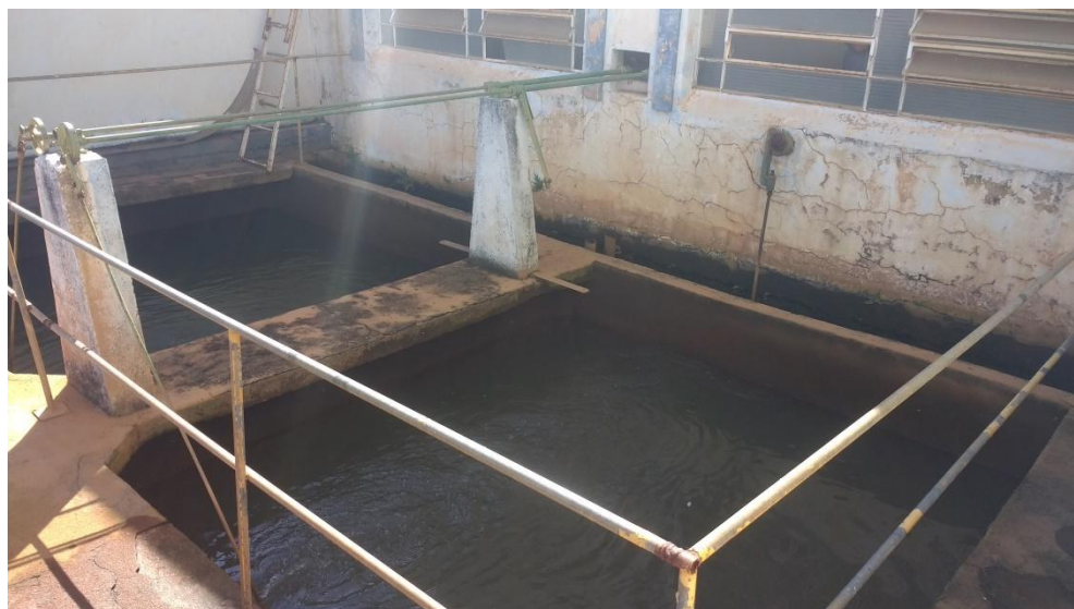
Figura 29 - Vista Geral de dois módulos de filtração
