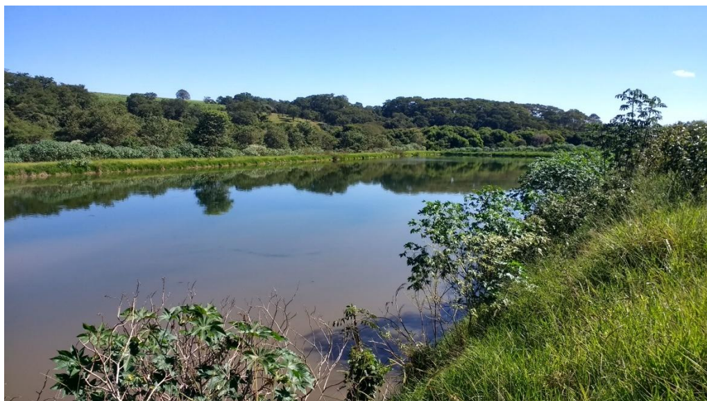
Figura 60 – Lagoa Facultativa ETE Orlândia
