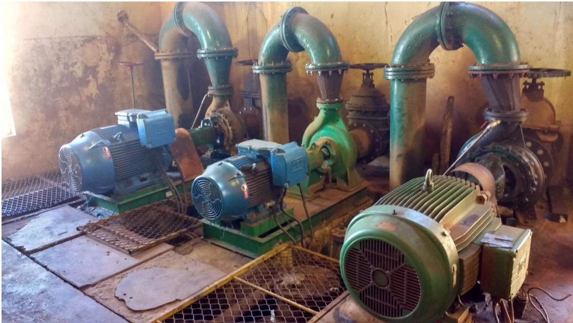
Figura 41 – Conjuntos Motobomba EEAB
