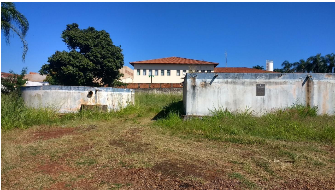
Figura 40 – Reservatórios CR ETA
