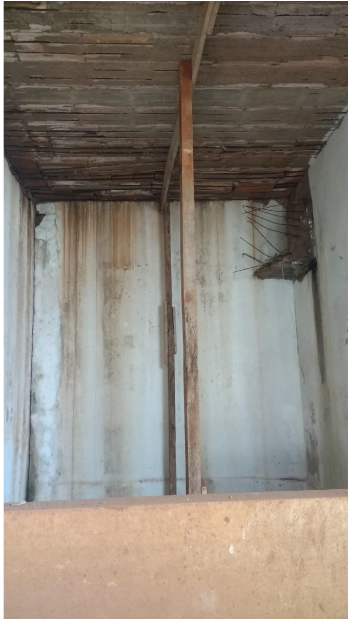
Figura 31 - Escoramento provisório de laje edifício ETA
