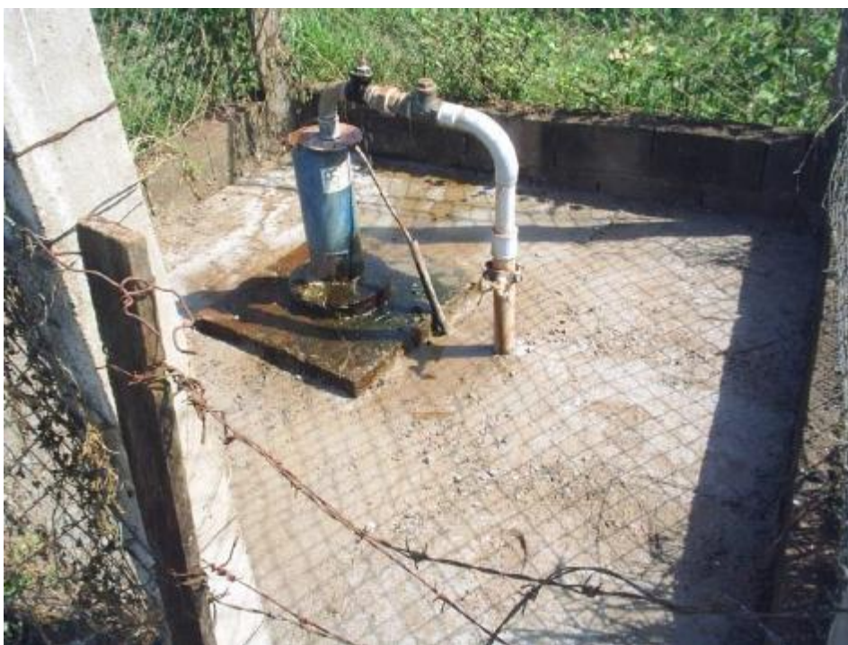
Figura 38 – Poço P10 – Capão do Meio
