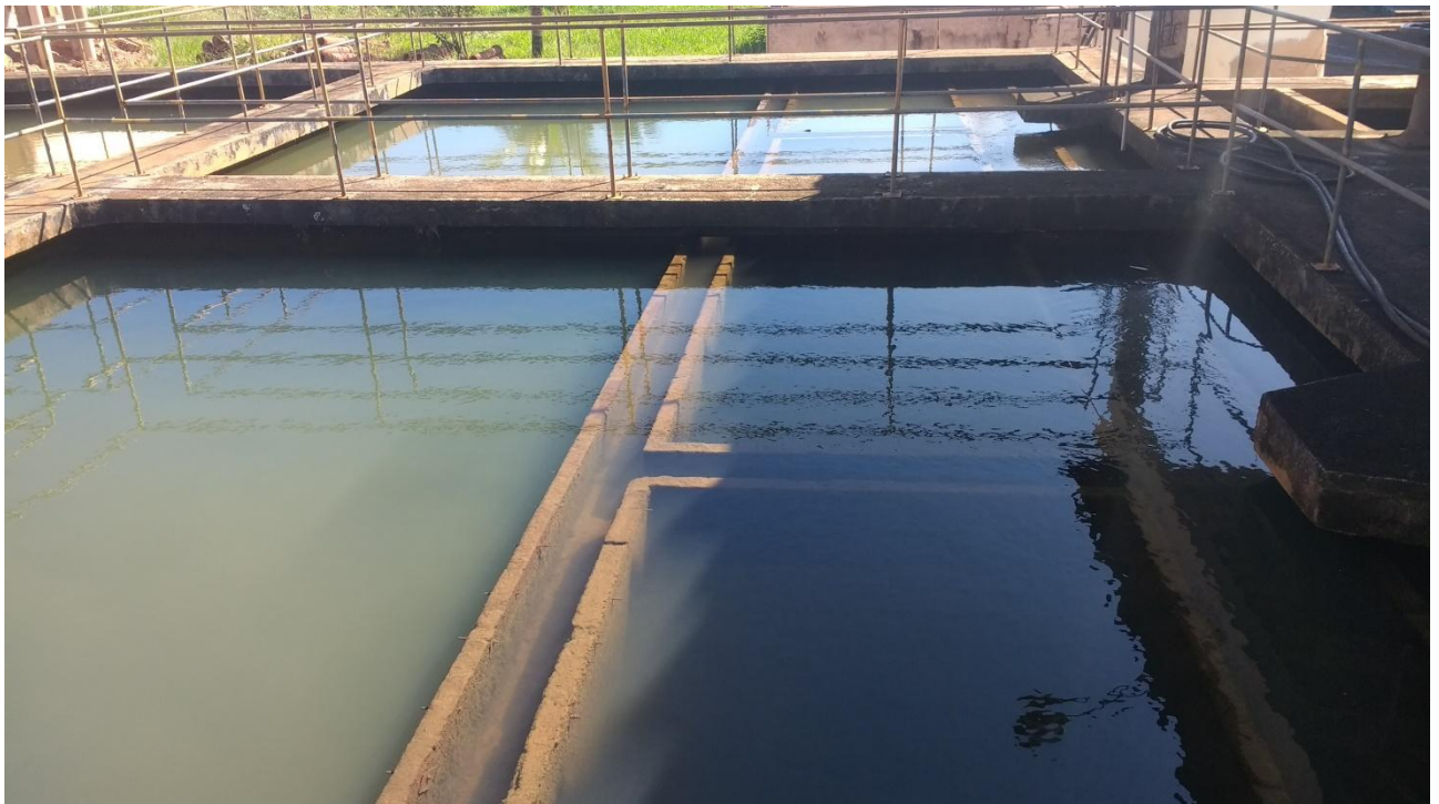
Figura 28 – Decantadores em operação afogados
