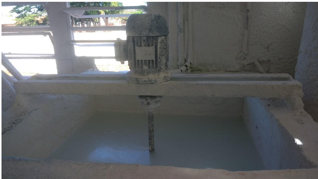
Figura 22 - Extintor de cal
