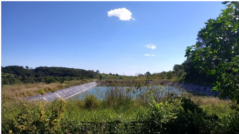
Figura 59 – Lagoa Anaeróbia ETE Orlândia
