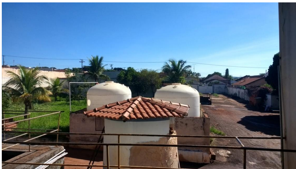
Figura 19 - Tanques de armazenamento de sulfato de alumínio
