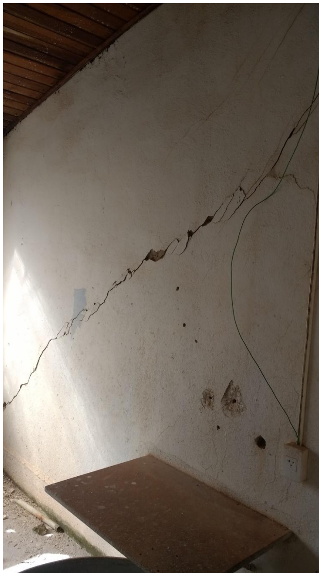
Figura 30 - Rachadura em parede do edifício da ETA
