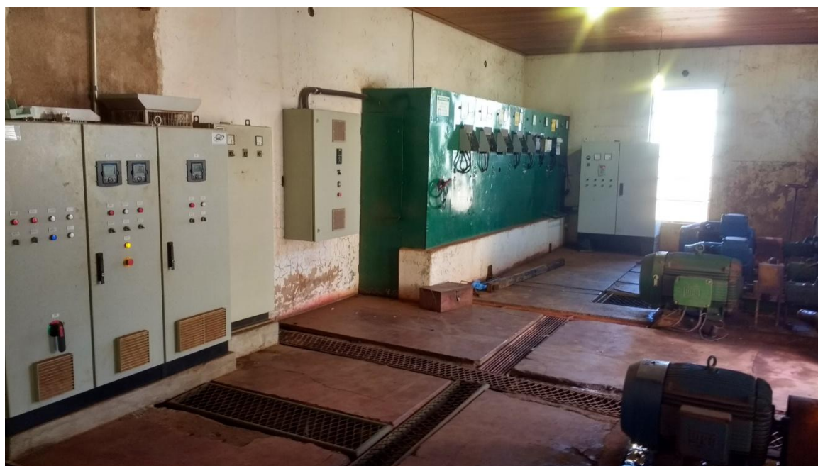
Figura 44 – EEAB e EEAT1
