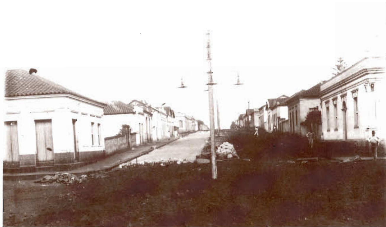
Calçamento da Rua 2.
