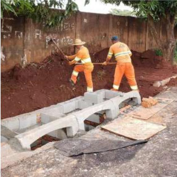
A Prefeitura de Orllândia está realizando obras de pavimentação asfáltica, no bairro Jardim Cidade Alta, no entorno do Centro de Lazer da "Vilinha". Juntamente ao asfalto, o local já recebeu as instalações de guias e, agora a construção de bocas de lobo, para captação das águas.
