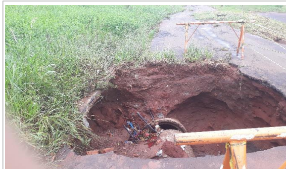
FOTO 2 - OBRA DE REP. GALERIAS - OBRA 1. Avenida Marginal "L" entre a Rua 03 e Rua 05.
