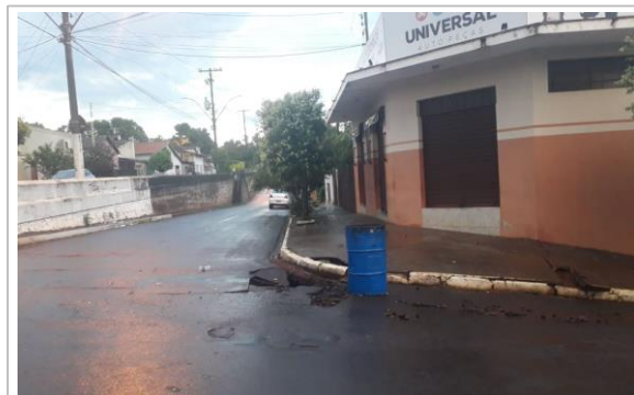
FOTO 6 - OBRA DE REP. GALERIAS - OBRA 3. Rua 08 Cruzamento com Avenida 01.
