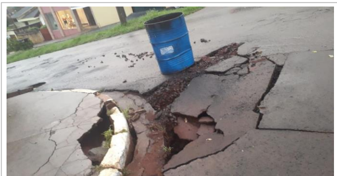
FOTO 5 - OBRA DE REP. GALERIAS - OBRA 3. Rua 08 Cruzamento com Avenida 01.
