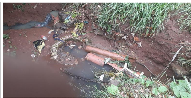
FOTO 3 - OBRA DE REP. REDE ESGOTO - OBRA 2. Avenida Marginal "L" entre a Rua 03 e Rua 05.
