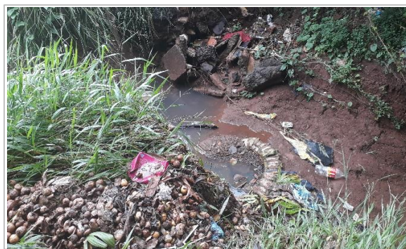
FOTO 4 - OBRA DE REP. REDE ESGOTO - OBRA 2. Avenida Marginal "L" entre a Rua 03 e Rua 05.
