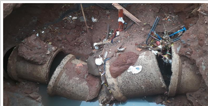
FOTO 1 - OBRA DE REP. GALERIAS - OBRA 1. Avenida Marginal "L" entre a Rua 03 e Rua 05.
