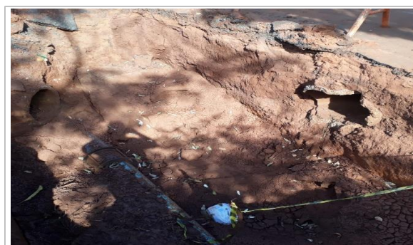
FOTO 10 - OBRA DE REP. GALERIAS - OBRA 5. Rua 04 Cruzamento com Avenida 01.
