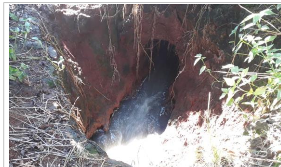
FOTO 12 - OBRA DE REP. REDE ESGOTO - OBRA 6. Zona Rural - Emissário passa pela Fazenda São João
