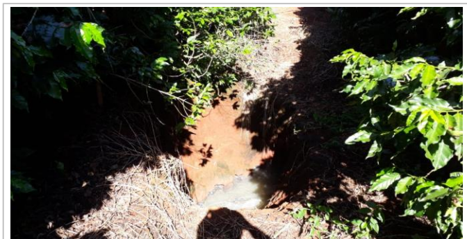
FOTO 11 - OBRA DE REP. REDE ESGOTO - OBRA 6. Zona Rural - Emissário passa pela Fazenda São João
