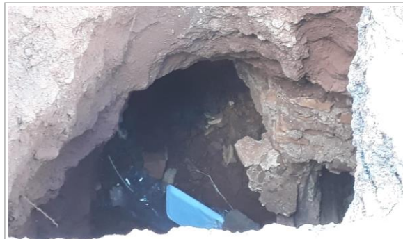
FOTO 8 - OBRA DE REP. GALERIAS - OBRA 4. Rua 04 Cruzamento com Avenida 01.
