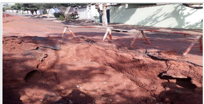
FOTO 9 - OBRA DE REP. GALERIAS - OBRA 5. Rua 04 Cruzamento com Avenida 01.
