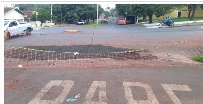
FOTO 7 - OBRA DE REP. GALERIAS - OBRA 4. Rua 04 Cruzamento com Avenida 01.
