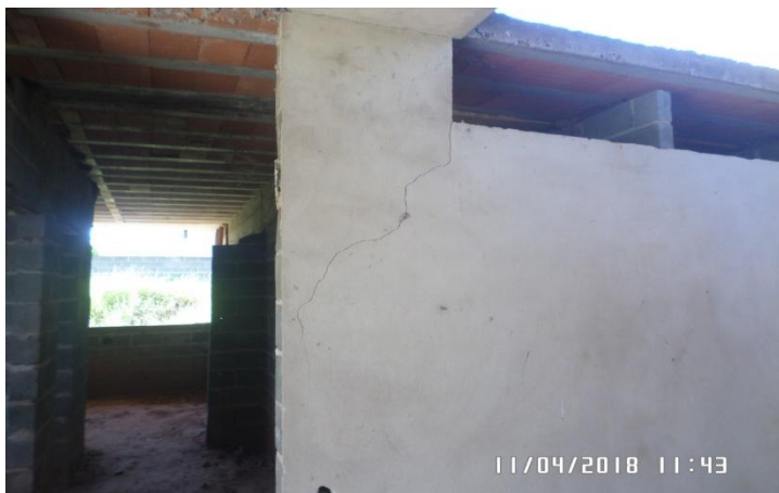
Imagem 09 - REBOCO COM TRINCOS
