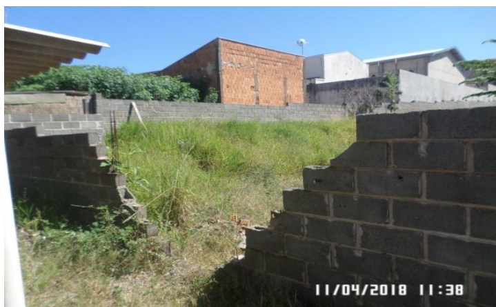
Imagem 03 - MURO E ÁREA EXTERNA
