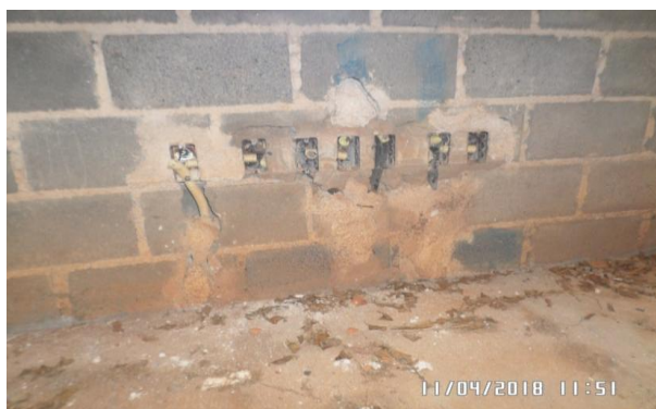
Imagem 16 - CAIXINHAS E MANGUEIRAS CORRUGADOS
