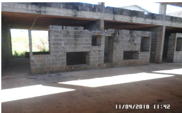
Imagem 07 - ALVENARIAS DEMOLIDAS EXTERNA
