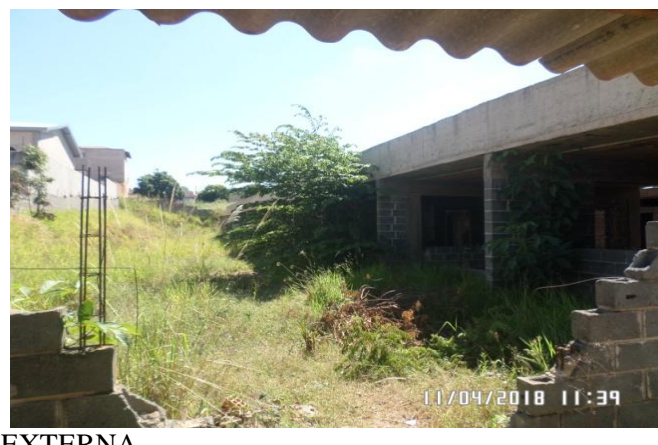
Imagem 04 - MURO E ÁREA
