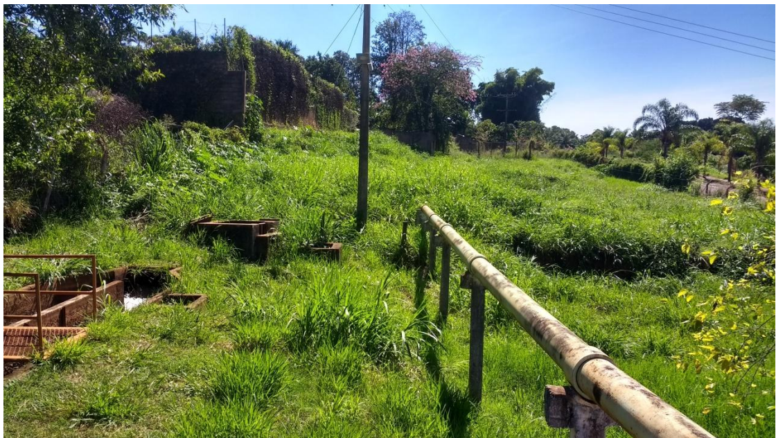
Figura 16 – Situação atual do Poço P1 e P5
