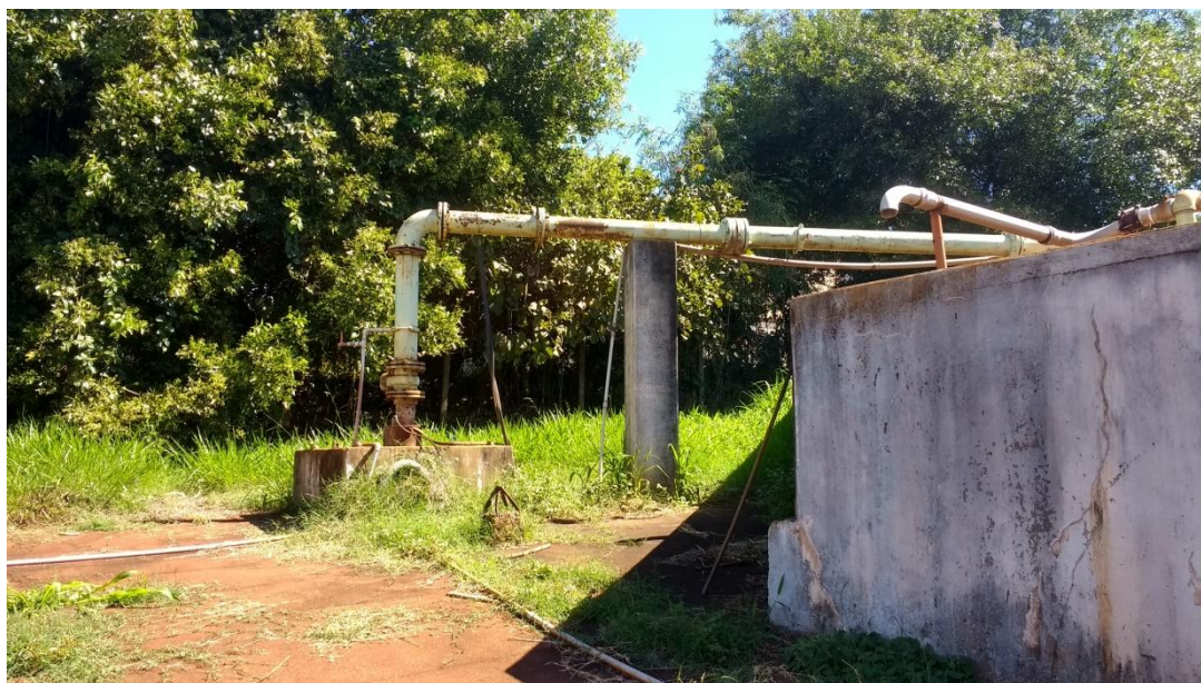
Figura 15 – Poço P1 e P5
