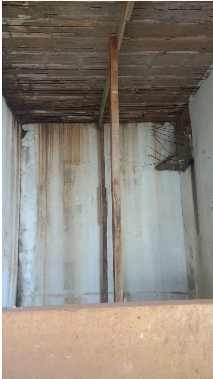
Figura 31 - Escoramento provisório de laje edifício ETA
