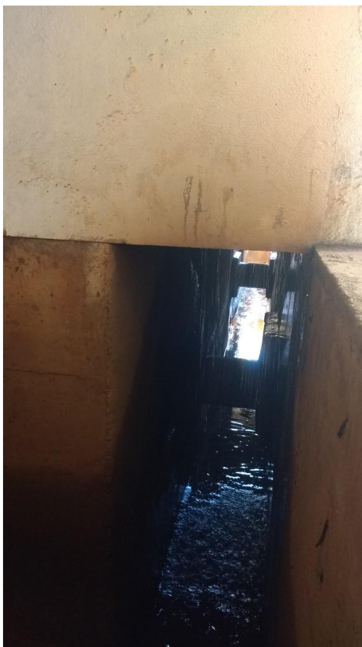
Figura 26 - Vazamento de grande proporção - ETA Orlândia
