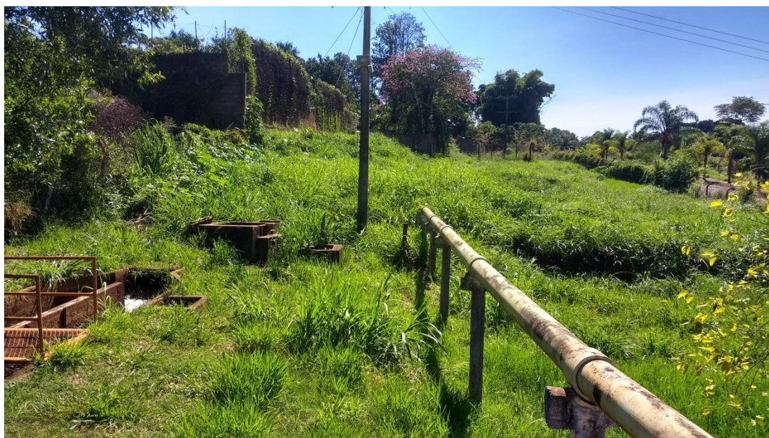
Figura 16 – Situação atual do Poço P1 e P5
