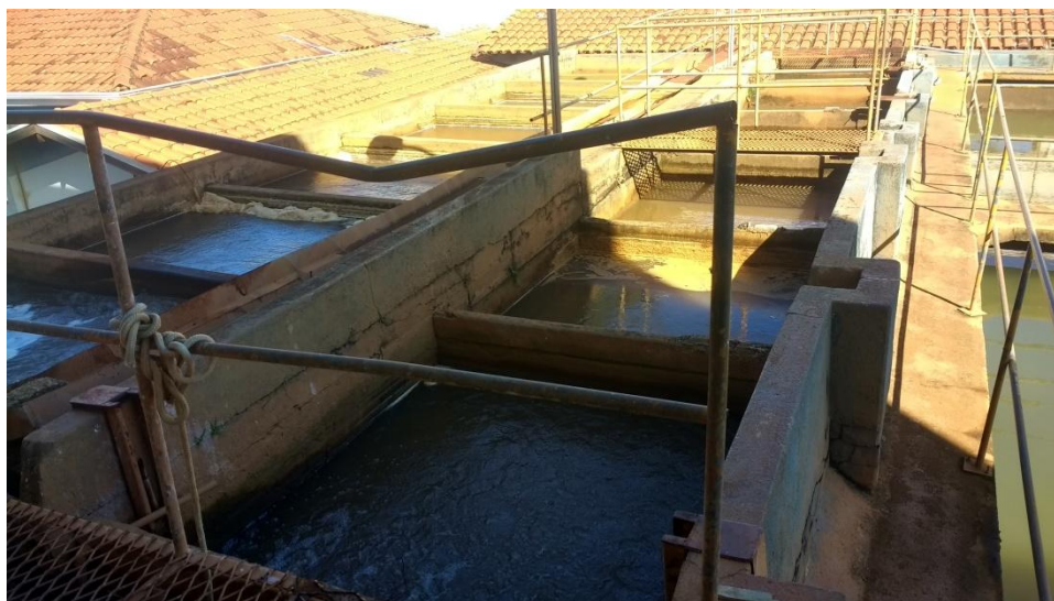
Figura 25 - Flocculadores da ETA de Orlandia
