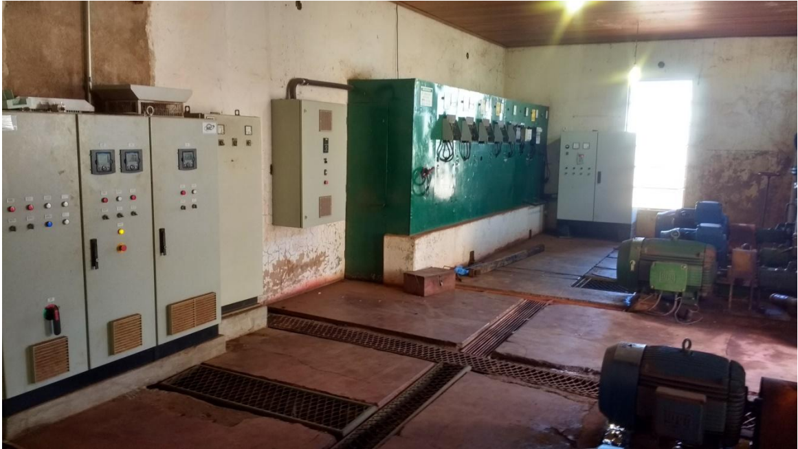
Figura 44 – EEAB e EEAT1
