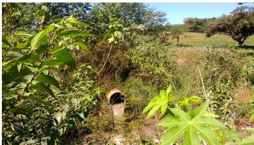
Figura 55 – Travessia Rompida no Ribeirão dos Agudos
