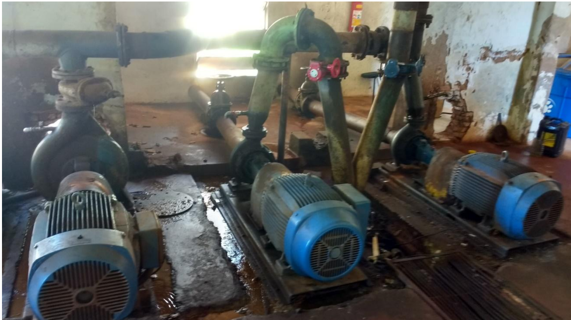
Figura 42 – Conjuntos Motobomba EEAT1
