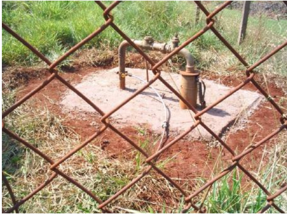
Figura 37 - Poço P4 - Marico
