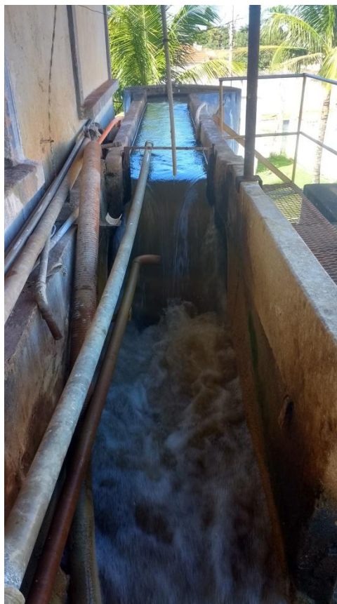
Figura 24 – Dispositivo de mistura rápida - ETA
