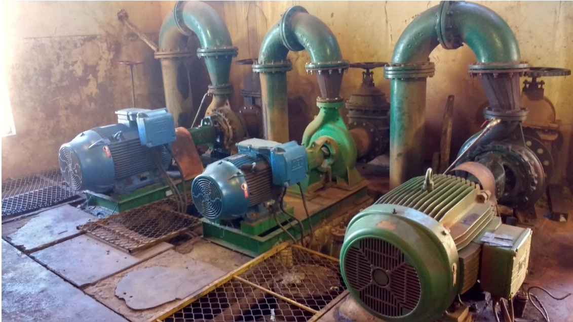
Figura 41 – Conjuntos Motobomba EEAB
