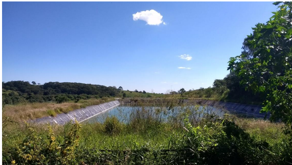
Figura 59 – Lagoa Anaeróbia ETE Orlândia
