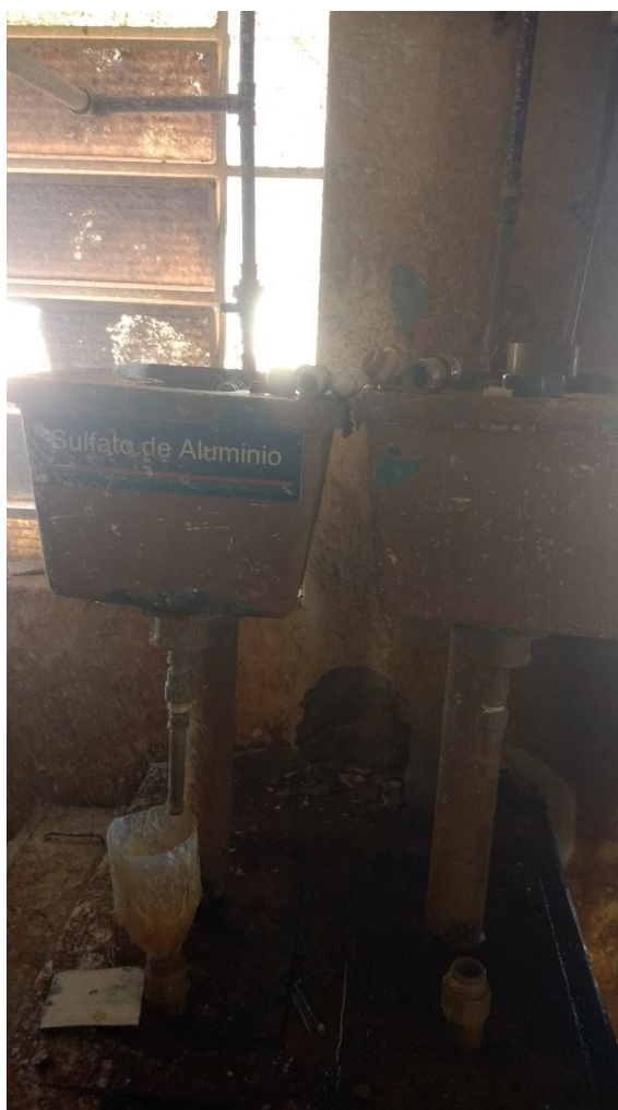
Figura 20 - Bomba dosadora de coagulante
