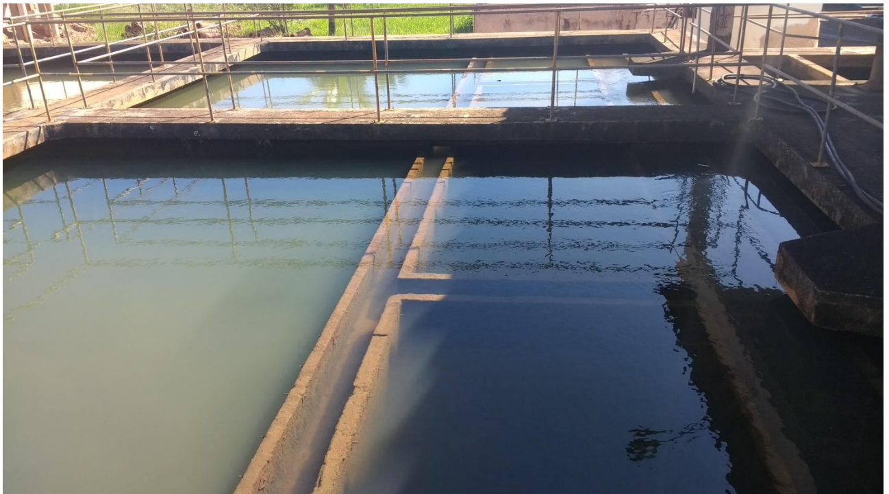
Figura 28 - Decantadores em operação afogados
