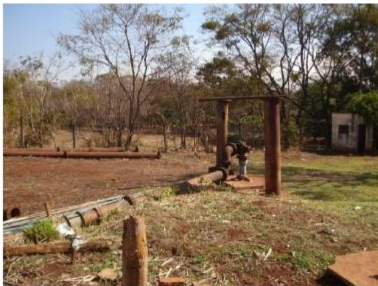
Figura 14 – Poço P3 - Gruta
