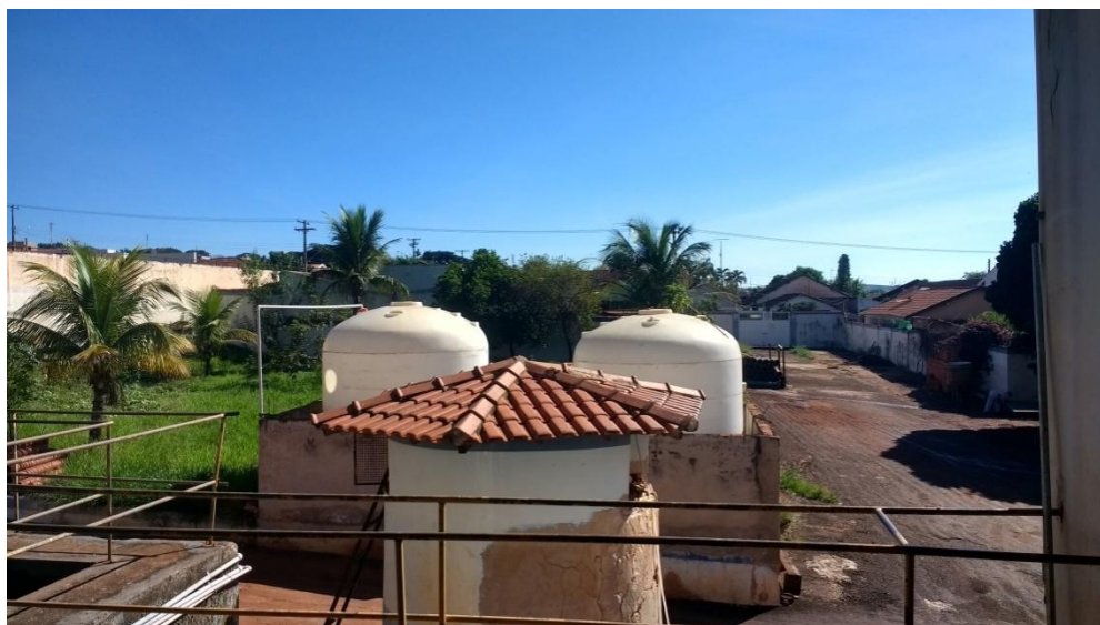
Figura 19 - Tanques de armazenamento de sulfato de alumínio
