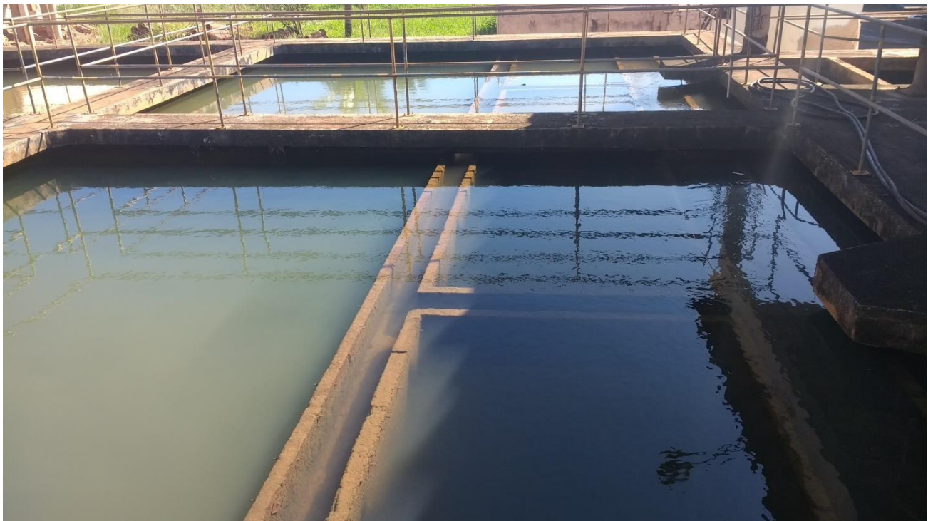
Figura 28 – Decantadores em operação afogados
