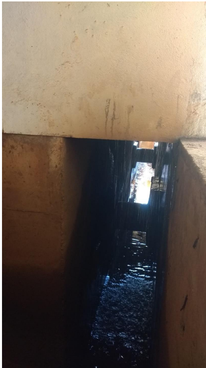
Figura 26 – Vazamento de grande proporção – ETA Orândia
