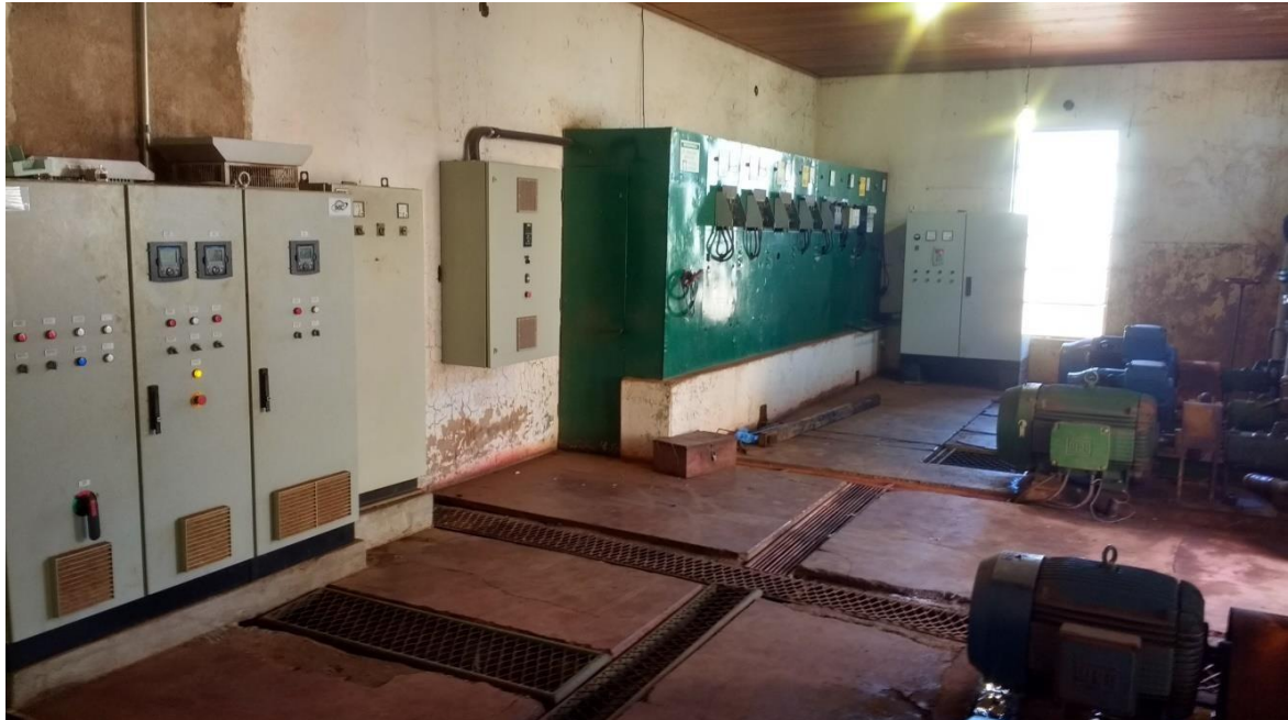
Figura 44 – EEAB e EEAT1
