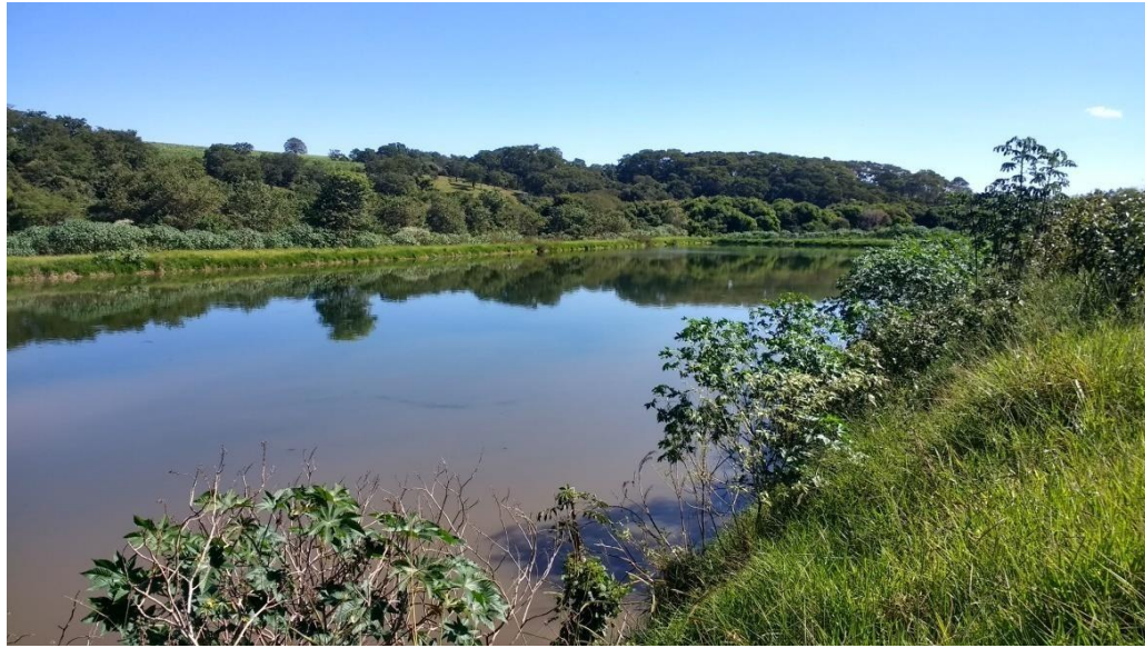
Figura 60 – Lagoa Facultativa ETE Orlandia
