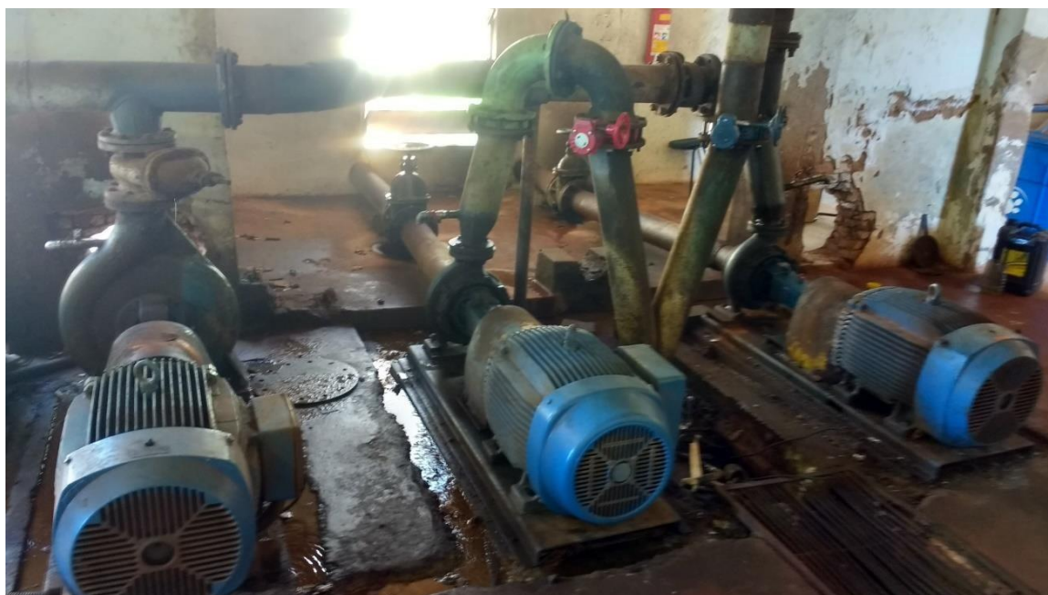
Figura 42 – Conjuntos Motobomba EEAT1
