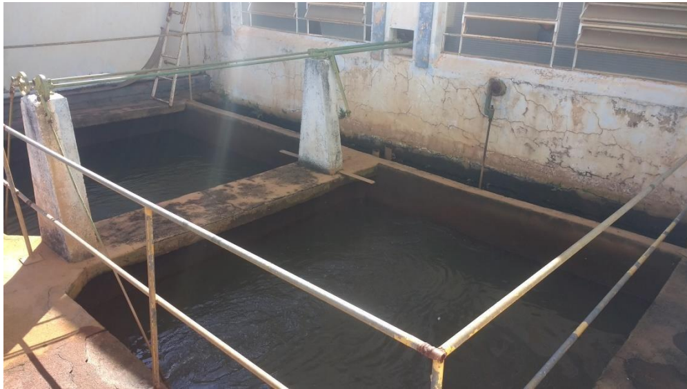
Figura 29 – Vista Geral de dois módulos de filtração
