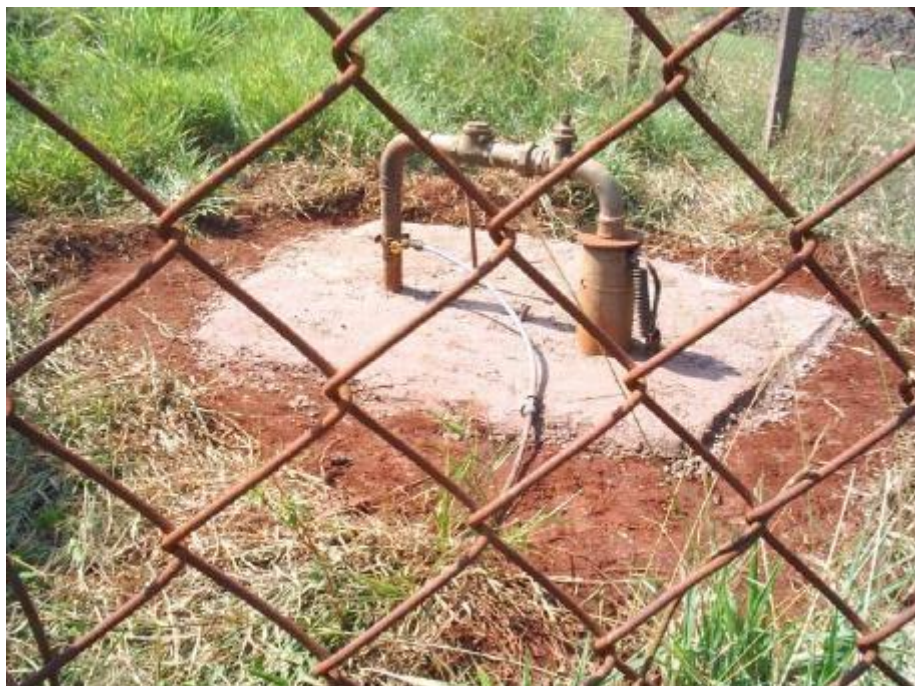
Figura 37 – Poço P4 - Marico
