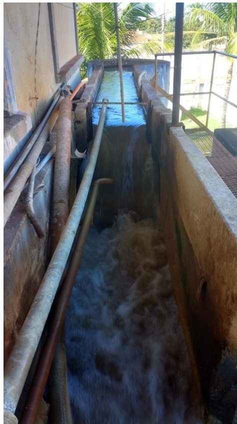
Figura 24 – Dispositivo de mistura rápida - ETA
