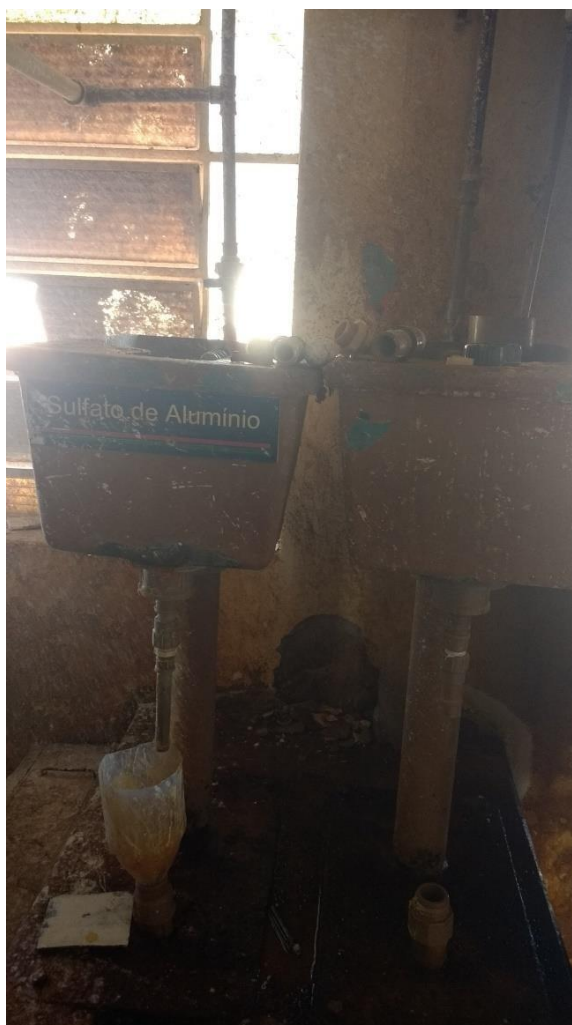
Figura 20 – Bomba dosadora de coagulante
