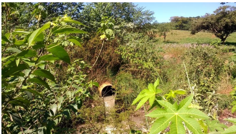
Figura 55 – Travessia Rompida no Ribeirão dos Agudos
