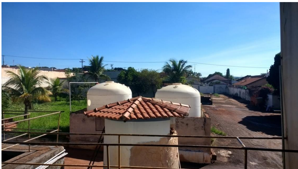
Figura 19 – Tanques de armazenamento de sulfato de alumínio
