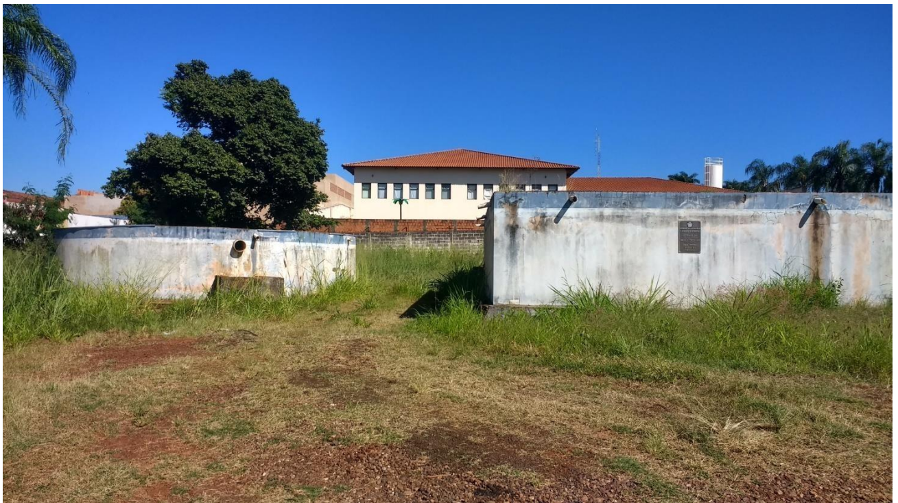
Figura 40 – Reservatórios CR ETA
