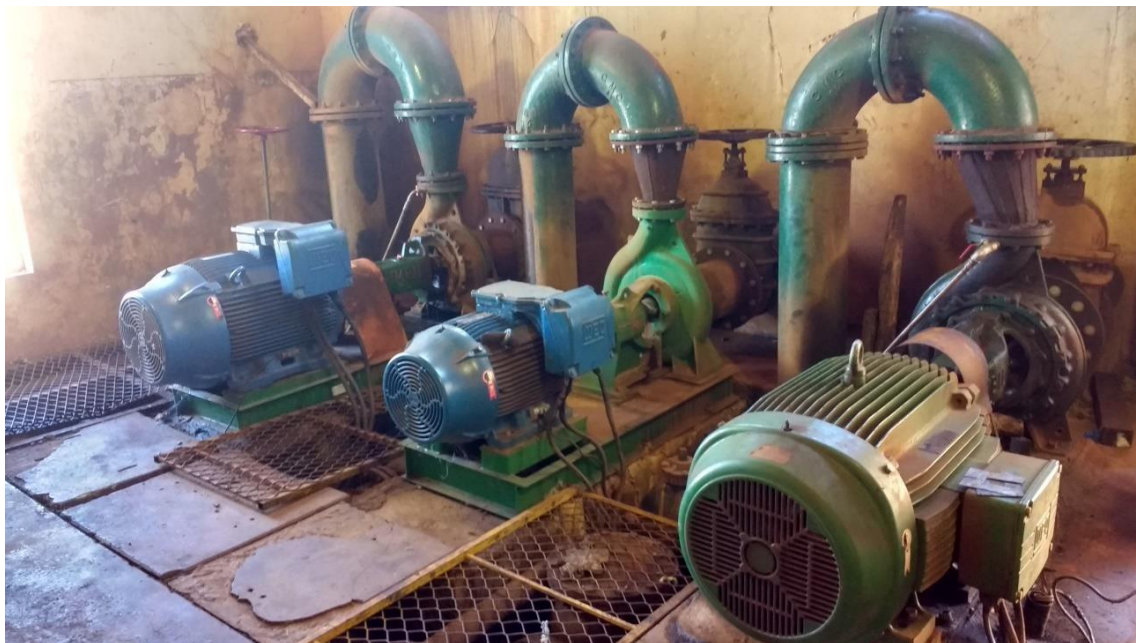
Figura 41 – Conjuntos Motobomba EEAB
