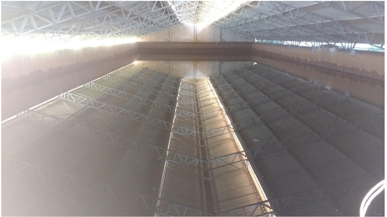
Figura 39 – Reservatório R5 – CR ETA
