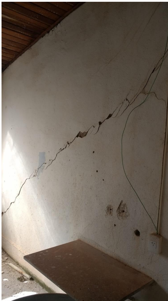
Figura 30 – Rachadura em parede do edifício da ETA
