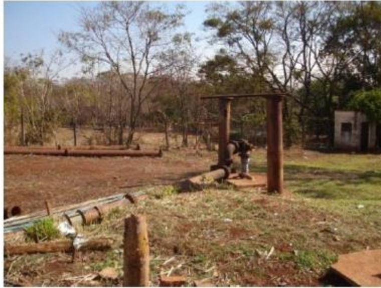
Figura 14 – Poço P3 - Gruta
