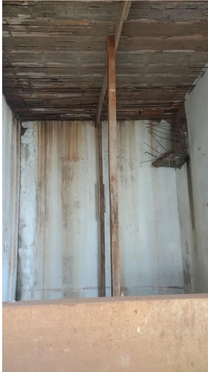
Figura 31 – Escoramento provisório de laje edifício ETA
