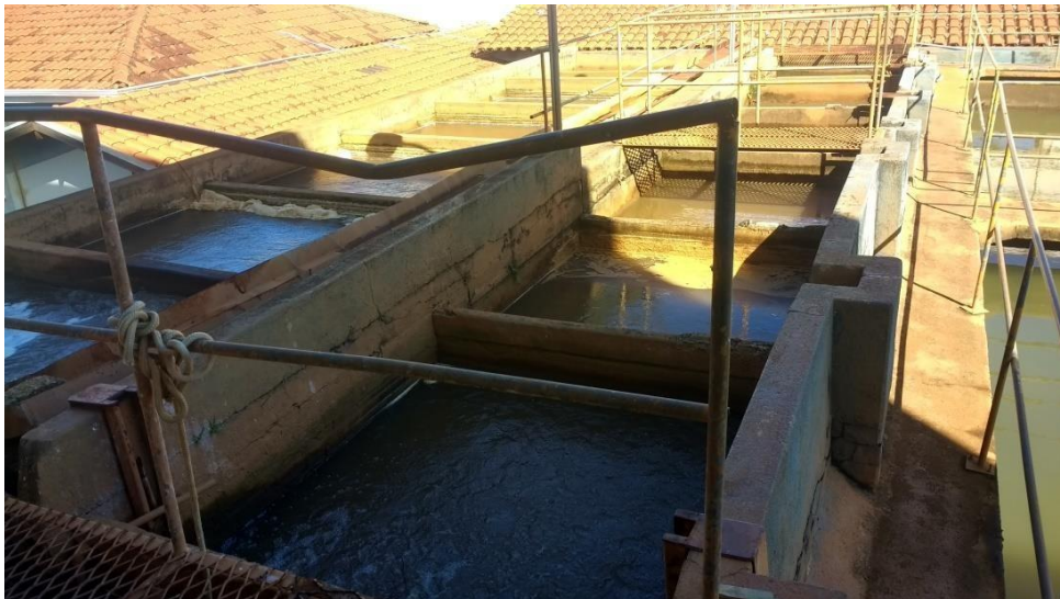
Figura 25 – Floculadores da ETA de Orlandia
