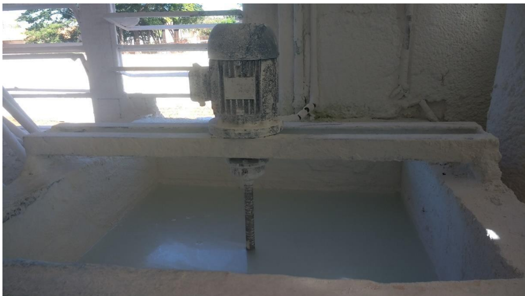
Figura 22 – Extintor de cal
