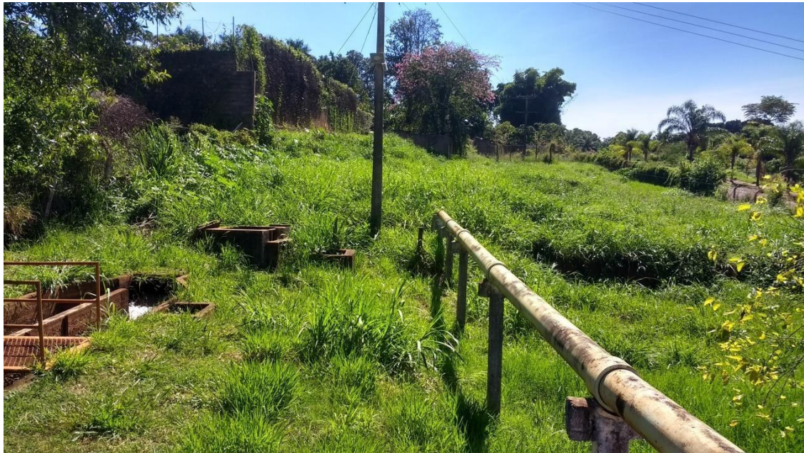
Figura 16 – Situação atual do Poço P1 e P5
