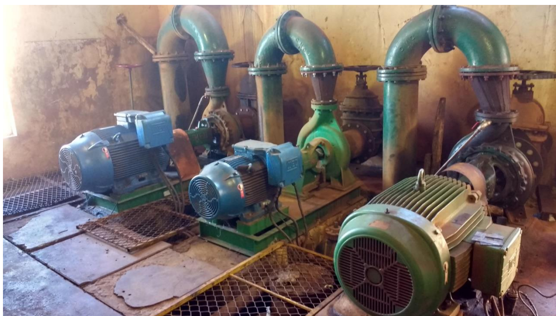
Figura 41 – Conjuntos Motobomba EEAB
