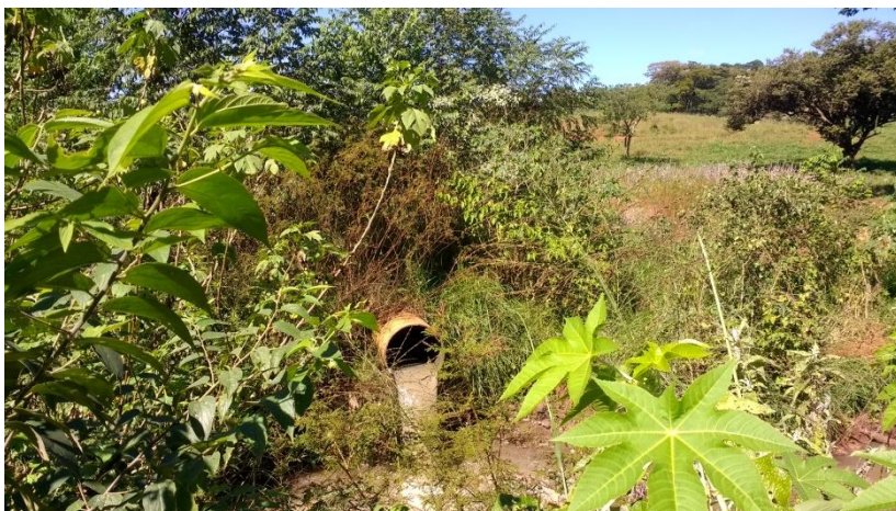
Figura 55 – Travessia Rompida no Ribeirão dos Agudos
