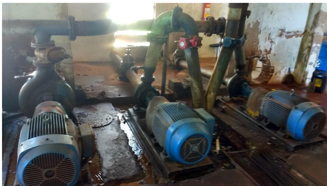
Figura 42 – Conjuntos Motobomba EEAT1
