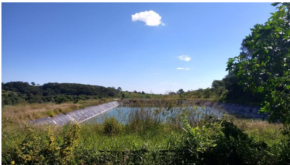
Figura 59 – Lagoa Anaeróbia ETE Orlandia
