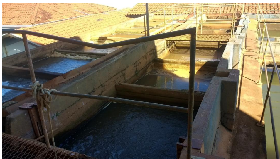
Figura 25 – Floculadores da ETA de Orlandia
