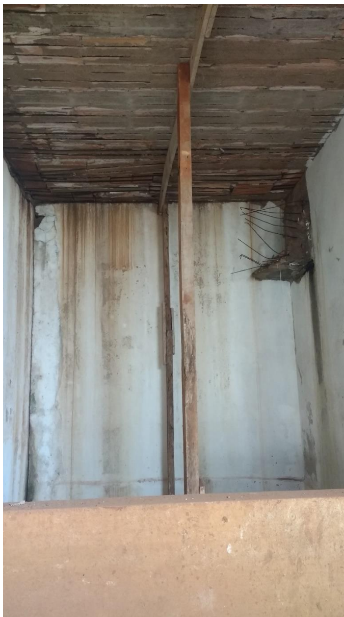
Figura 31 – Escoramento provisório de laje edifício ETA
