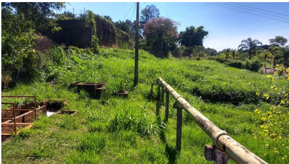
Figura 16 – Situação atual do Poço P1 e P5
