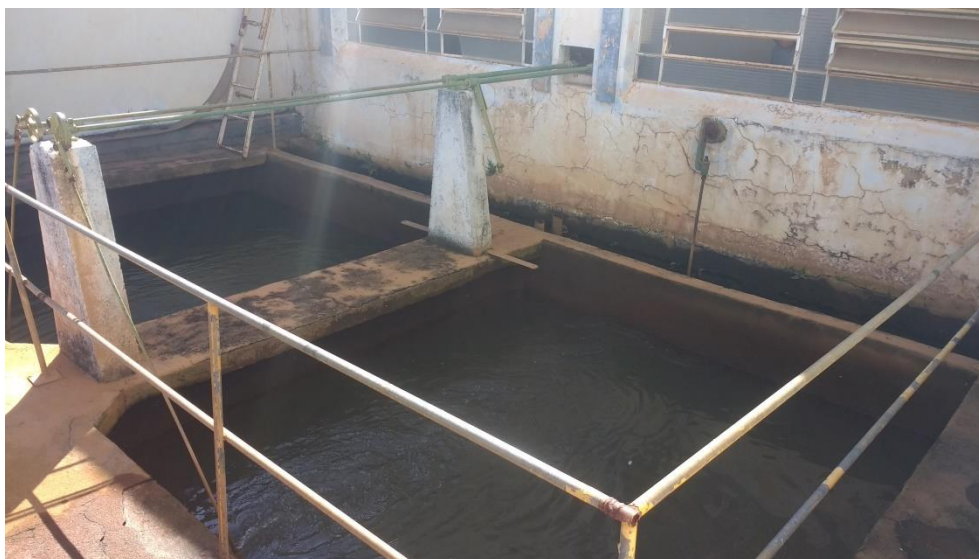
Figura 29 – Vista Geral de dois módulos de filtração
