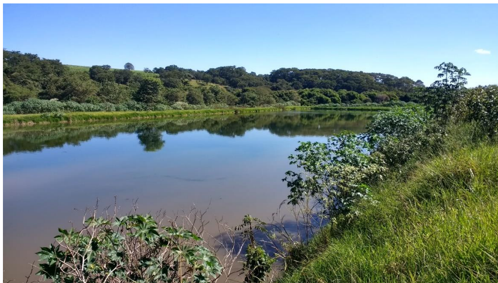
Figura 60 – Lagoa Facultativa ETE Orlandia
