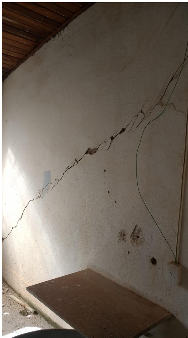
Figura 30 – Rachadura em parede do edifício da ETA
