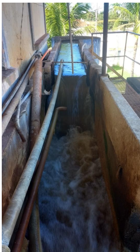
Figura 24 – Dispositivo de mistura rápida - ETA
