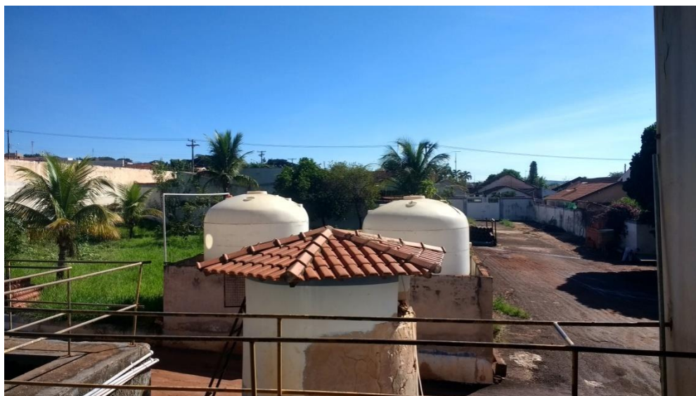
Figura 19 – Tanques de armazenamento de sulfato de alumínio
