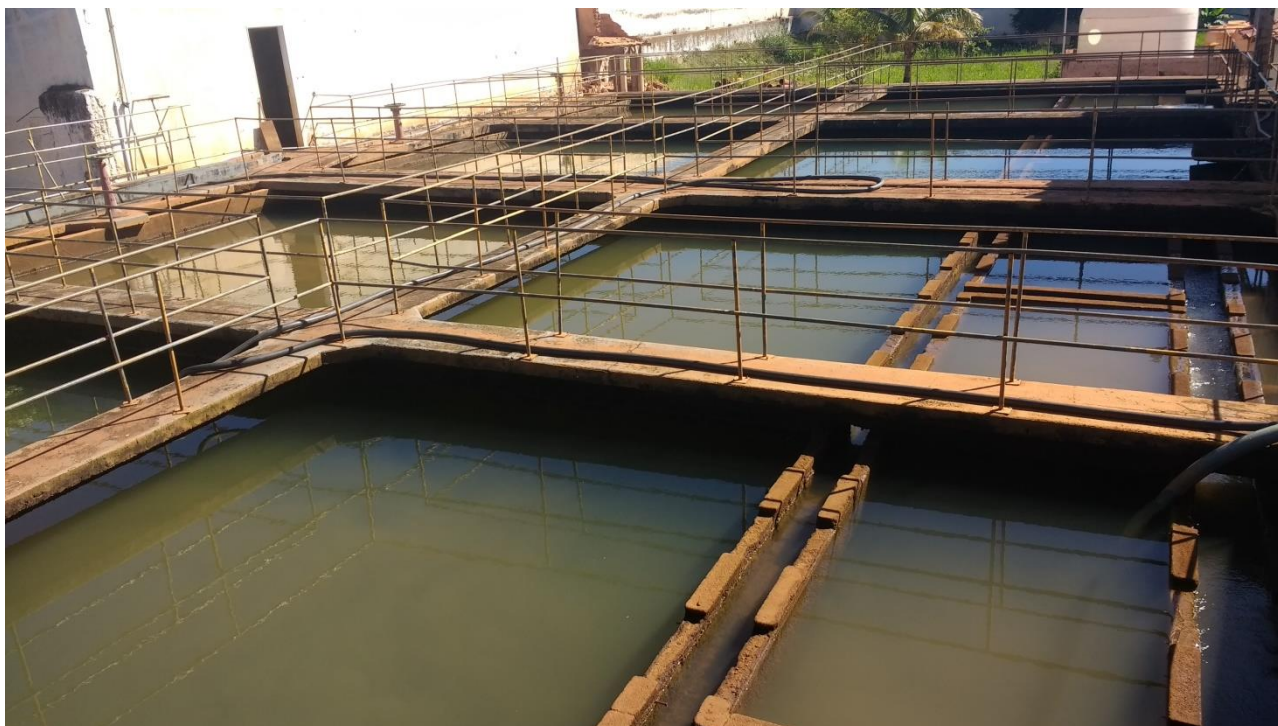
Figura 27 – Vista Geral dos decantadores, sendo duas unidades operando afogados
