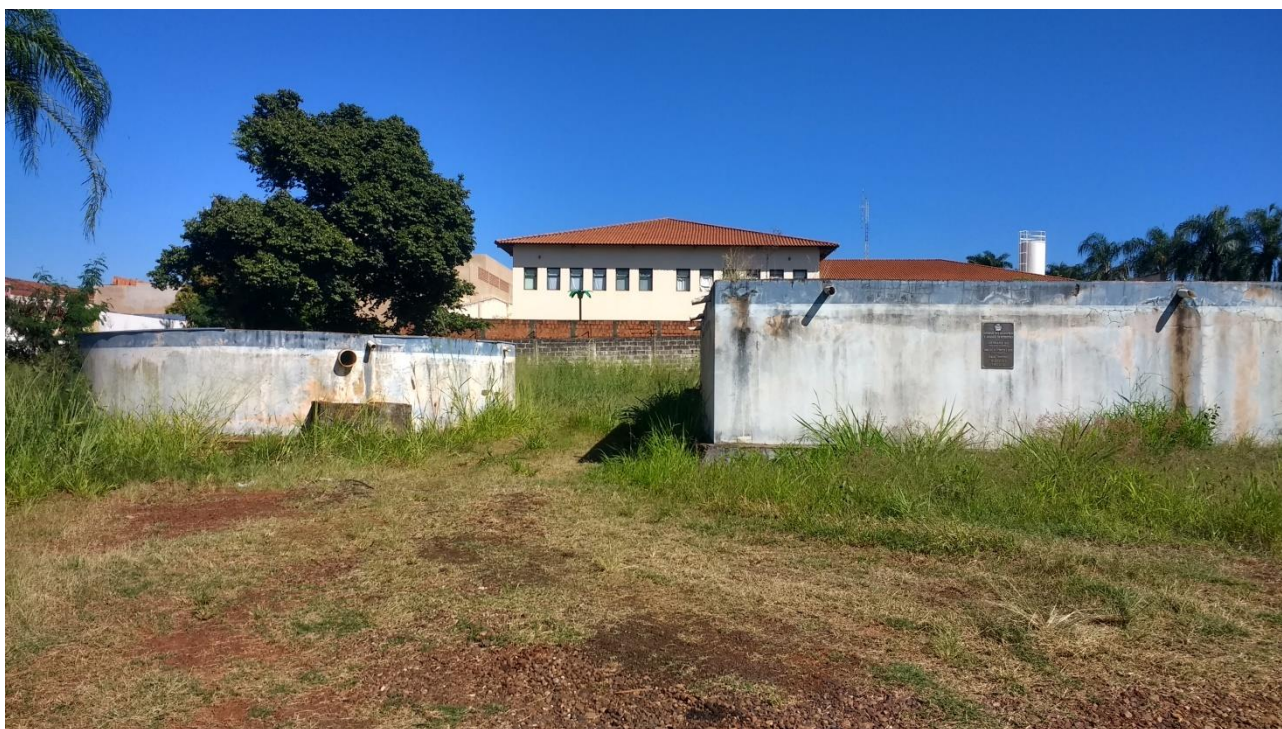
Figura 40 – Reservatórios CR ETA
