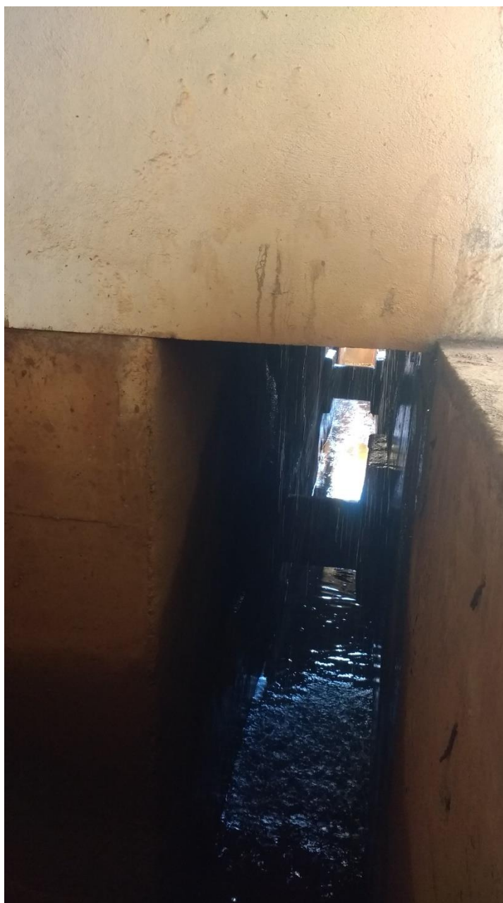
Figura 26 – Vazamento de grande proporção – ETA Orlandia
