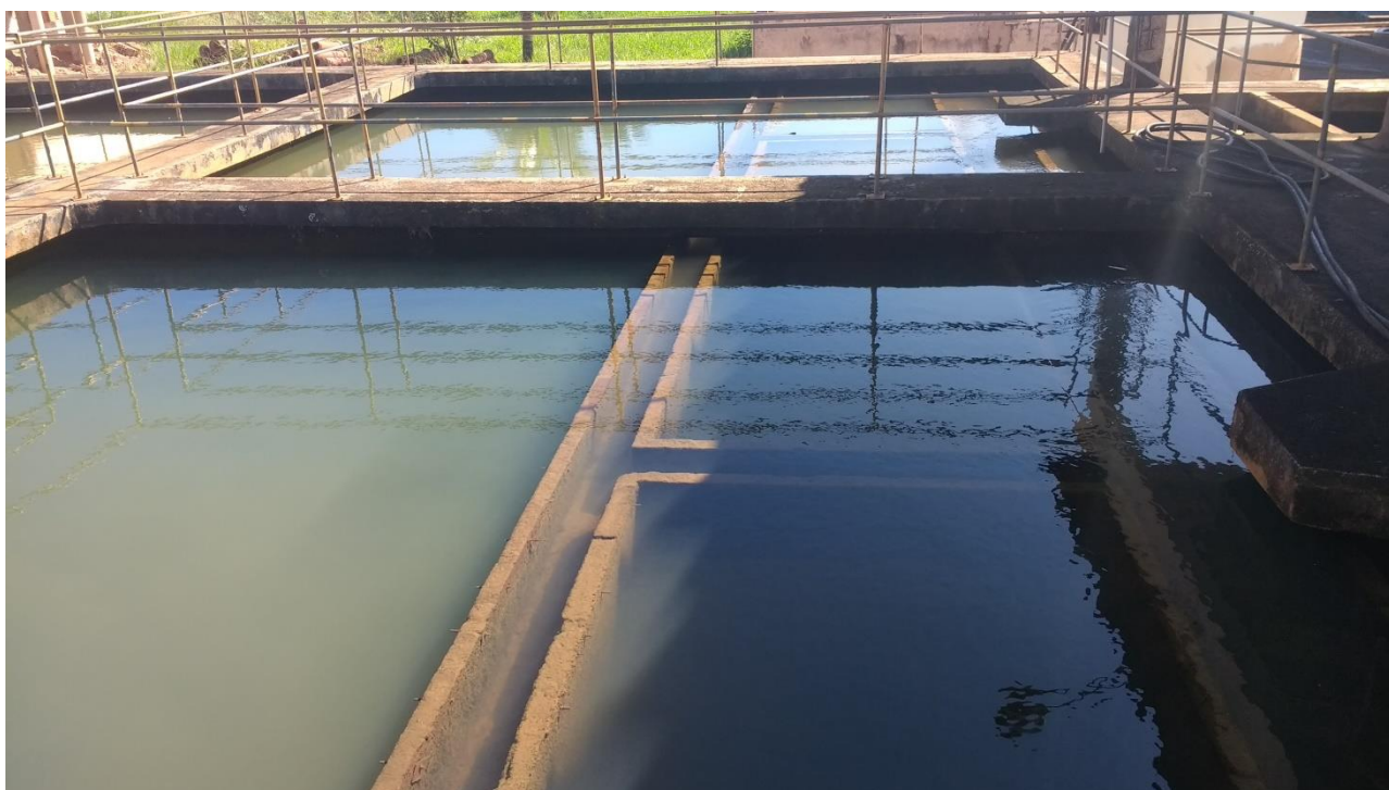
Figura 28 – Decantadores em operação afogados
