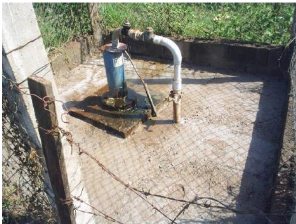
Figura 38 – Poço P10 – Capão do Meio
