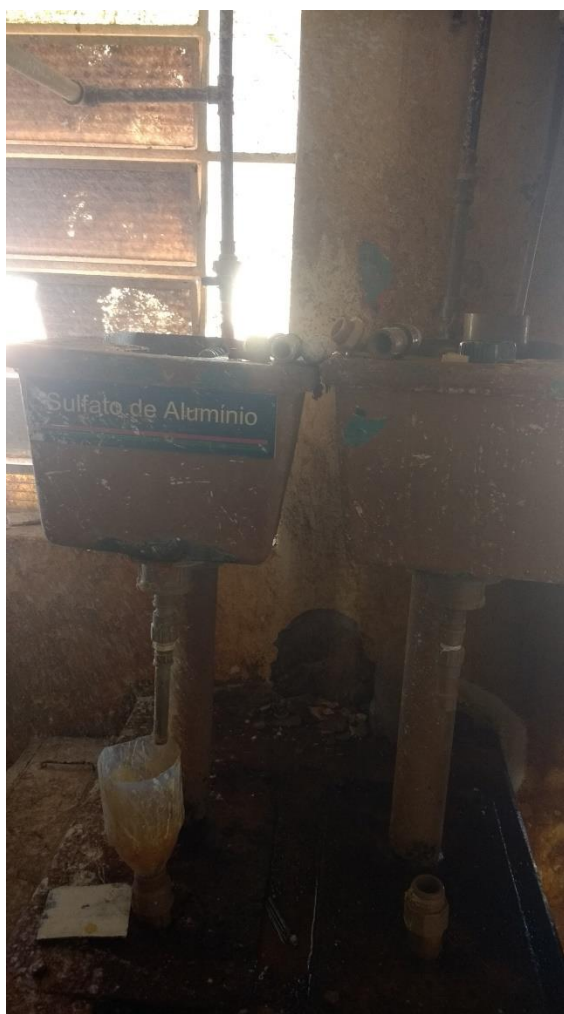
Figura 20 – Bomba dosadora de coagulante
