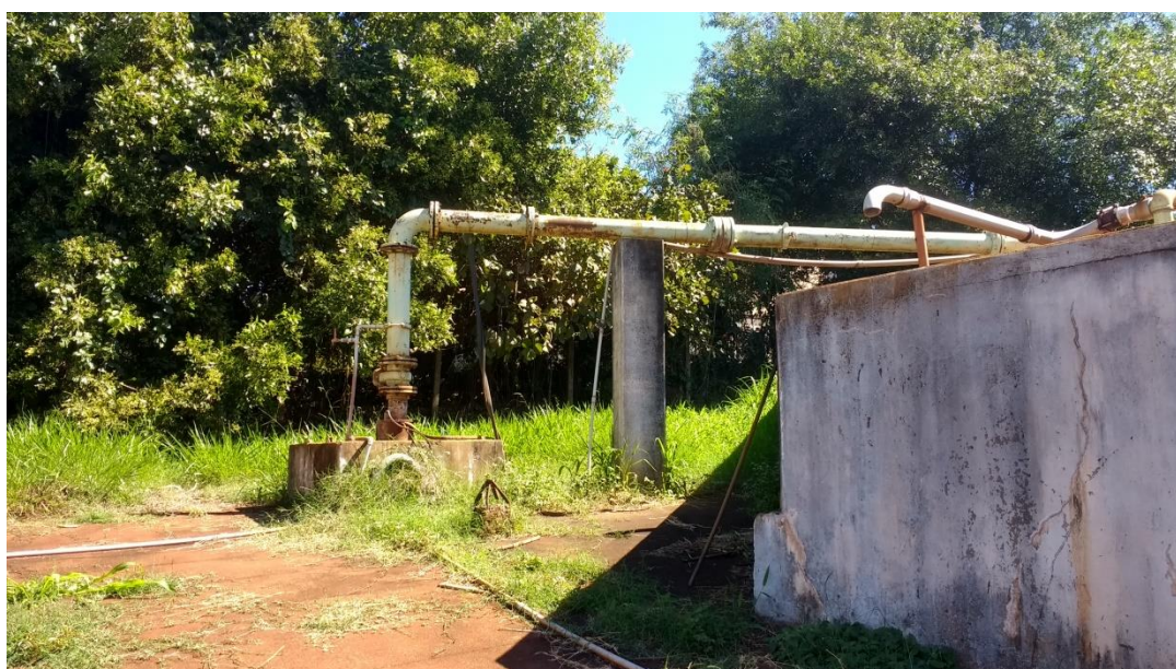
Figura 15 – Poço P1 e P5
