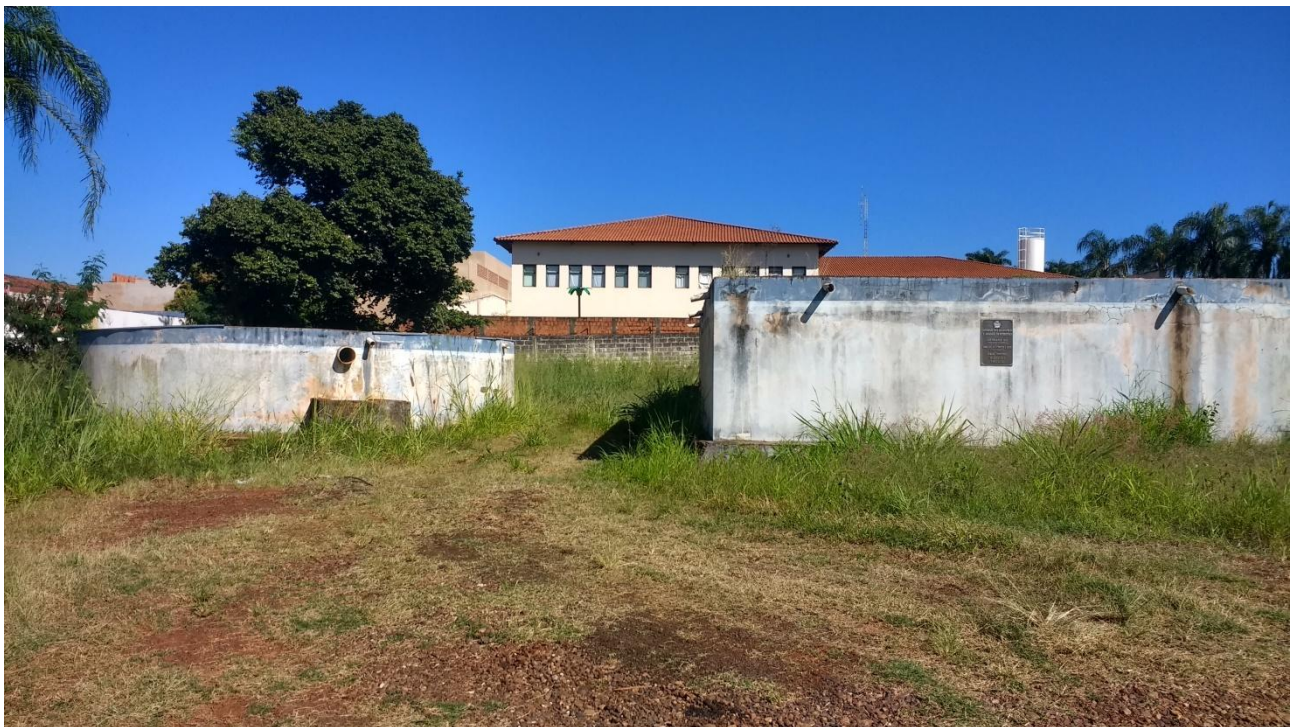
Figura 40 – Reservatórios CR ETA
