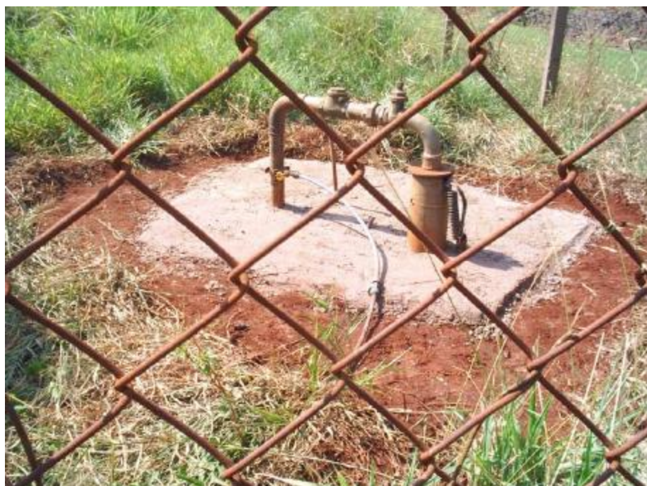
Figura 37 – Poço P4 - Marico
