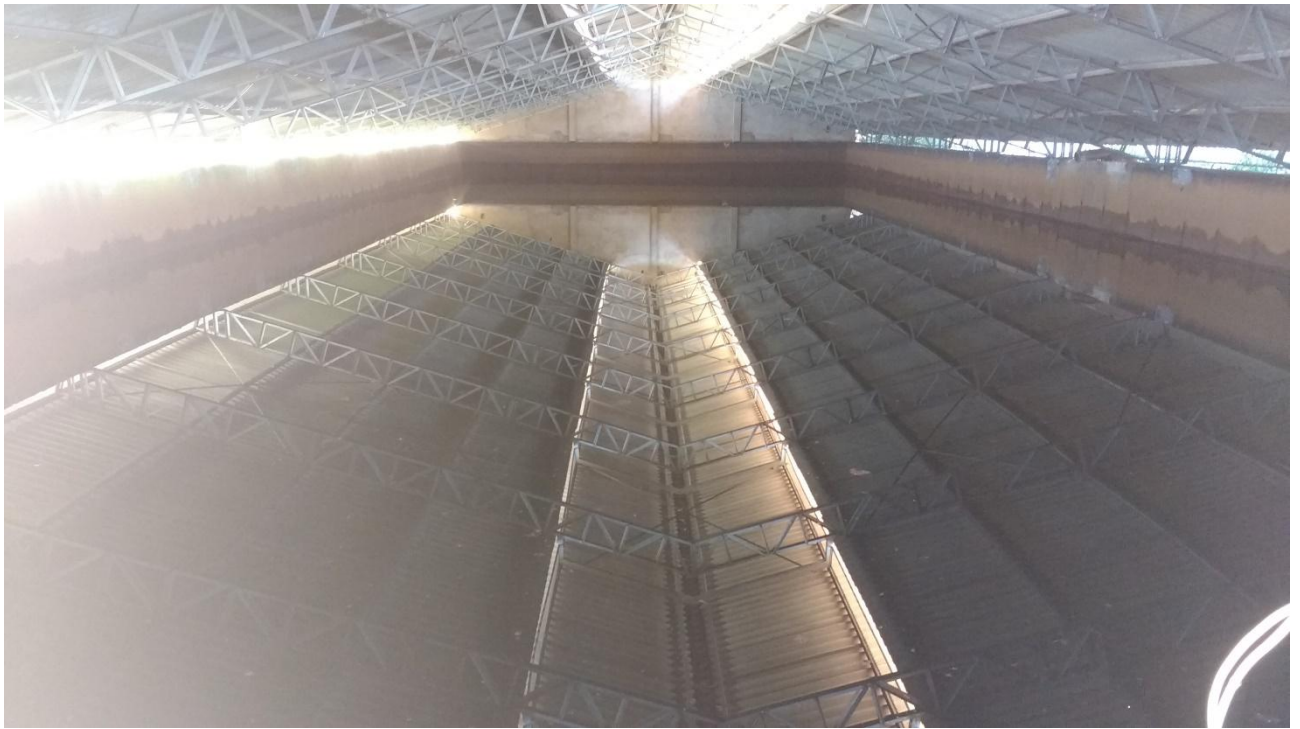
Figura 39 – Reservatório R5 – CR ETA
