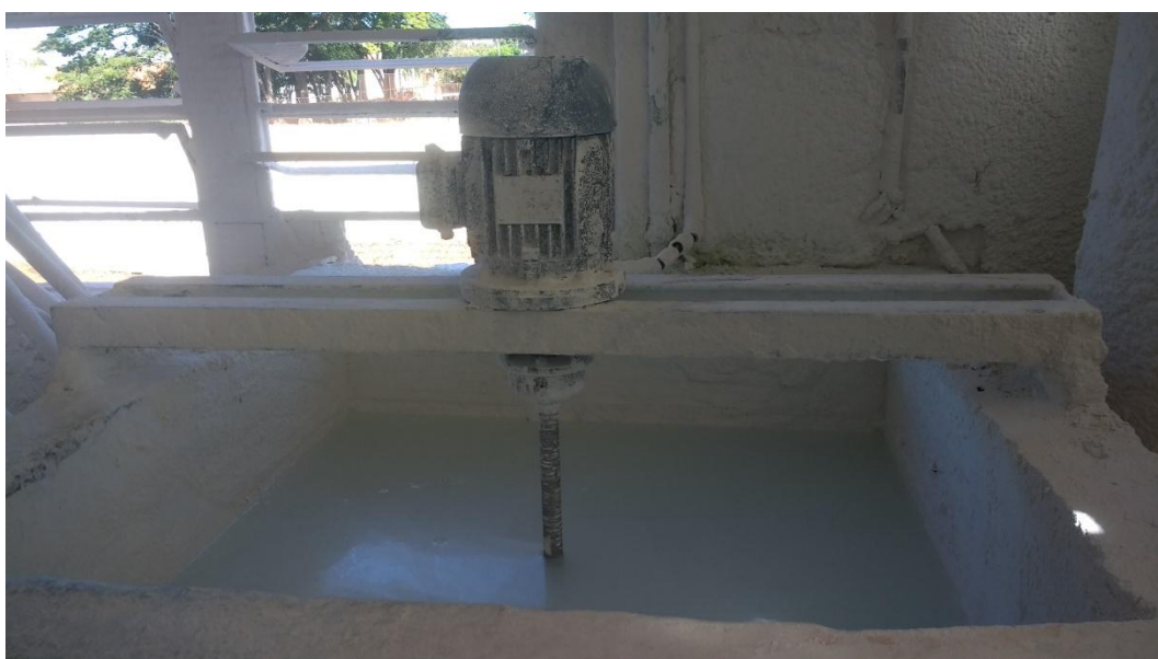
Figura 22 – Extintor de cal
