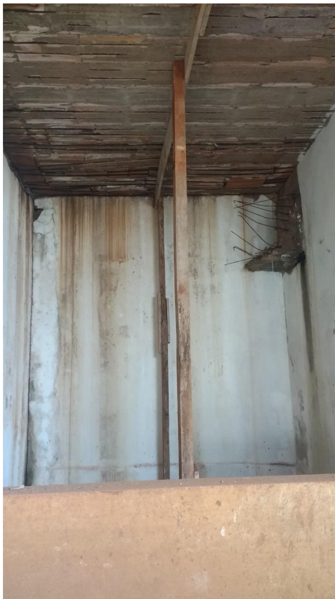
Figura 31 – Escoramento provisório de laje edifício ETA
