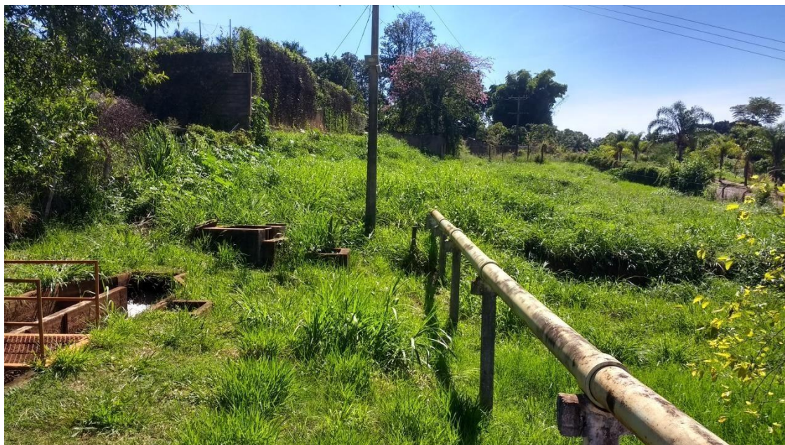
Figura 16 – Situação atual do Poço P1 e P5
