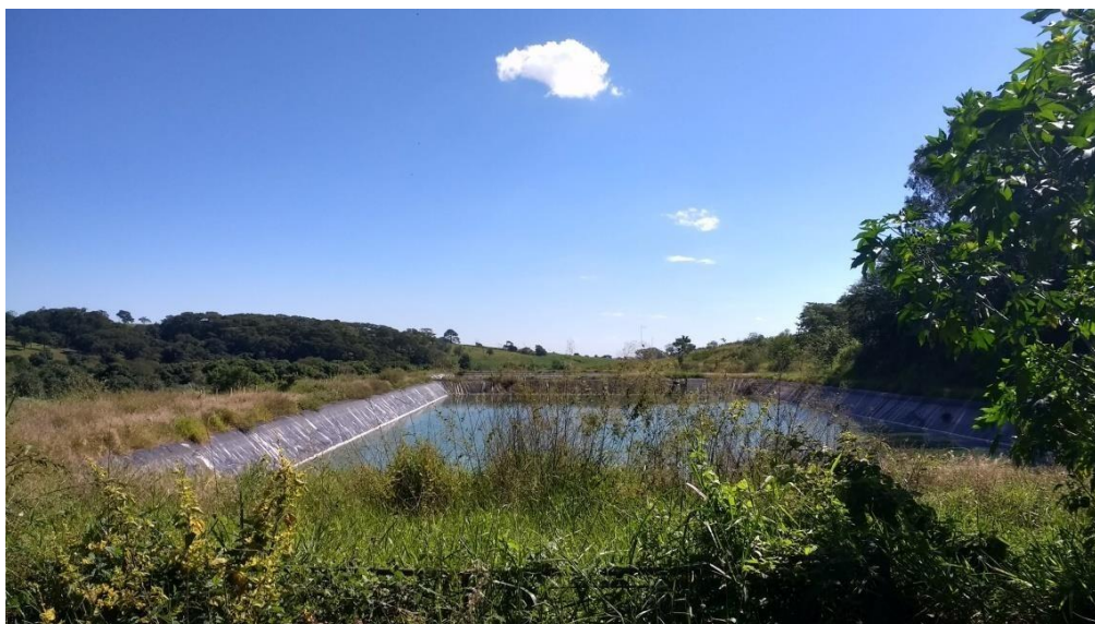
Figura 59 – Lagoa Anaeróbia ETE Orândia
