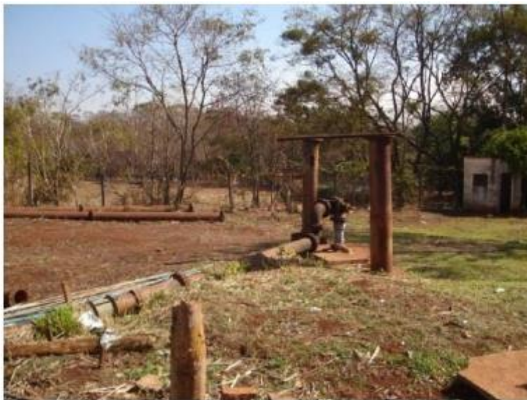
Figura 14 – Poço P3 - Gruta
