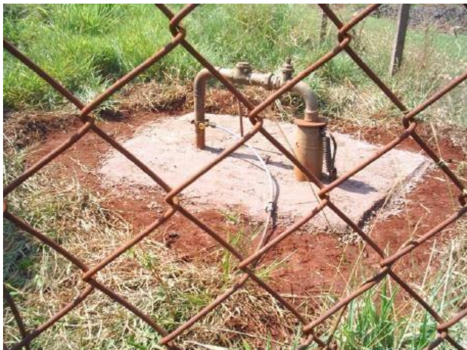
Figura 37 – Poço P4 - Marico
