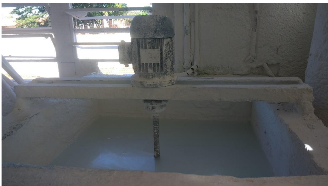
Figura 22 – Extintor de cal
