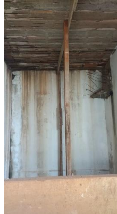
Escoramento provisório de laje do edifício da ETA
