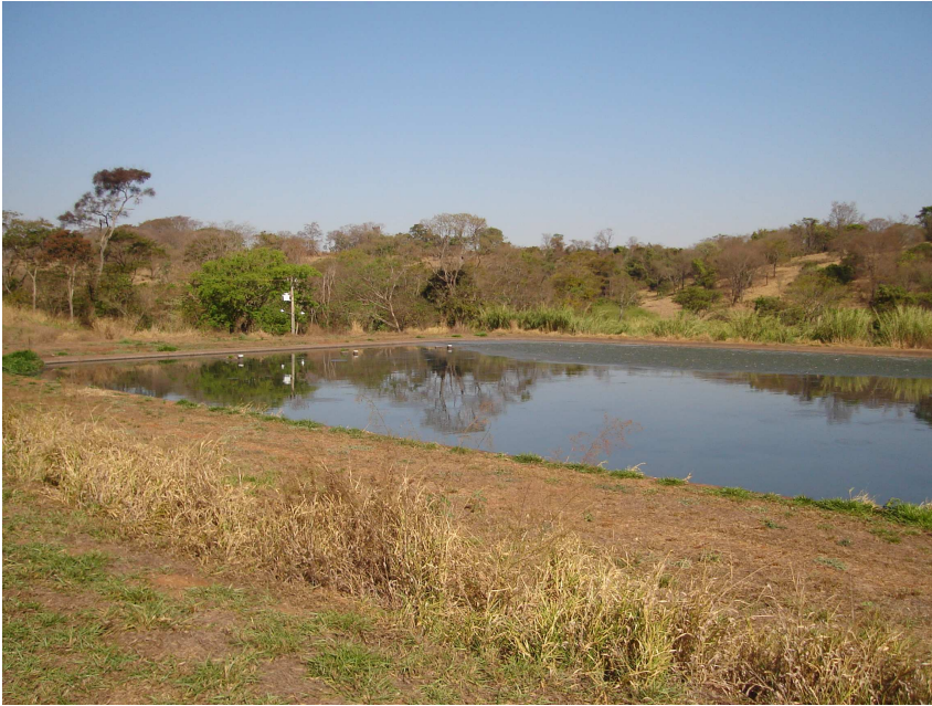
Ilustração 5.42 - Vista parcial, no sentido de jusante para montante, da lagoa anaeróbia do módulo em operação.
