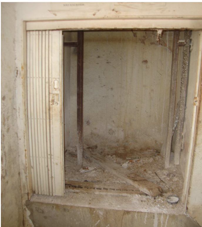
Ilustração 5.24- Monta carga para transporte das sacas e cal e de sulfato de alumínio
