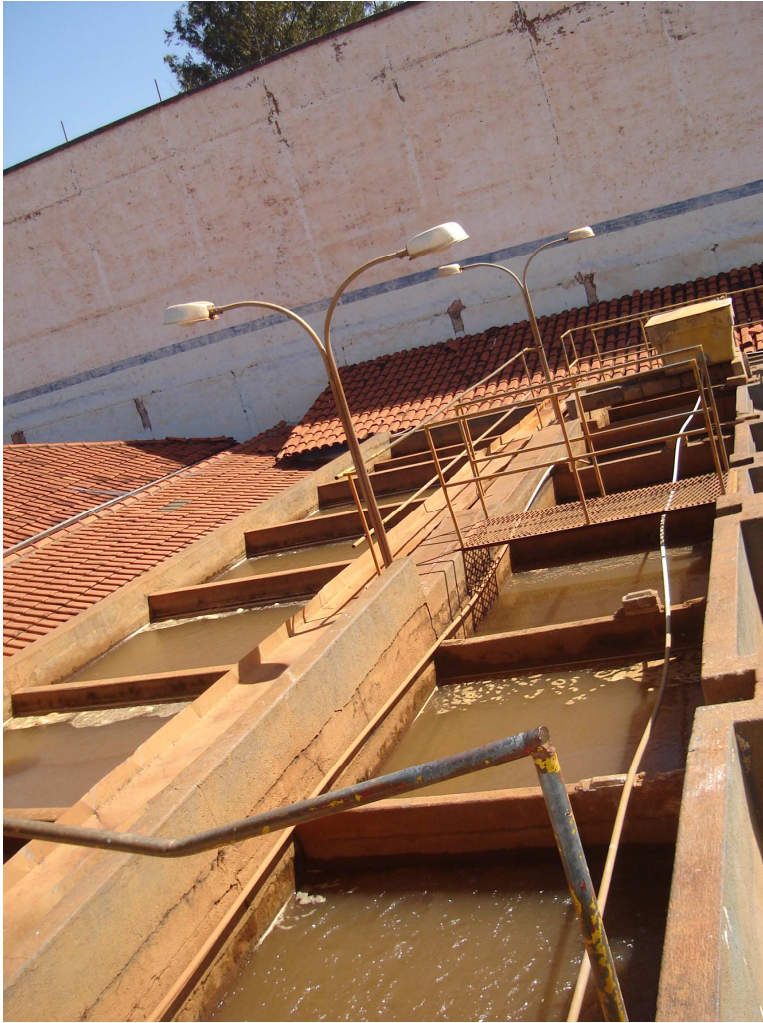
Ilustração 5.12 Vista dos flocculadores a partir de sua porção de montante
