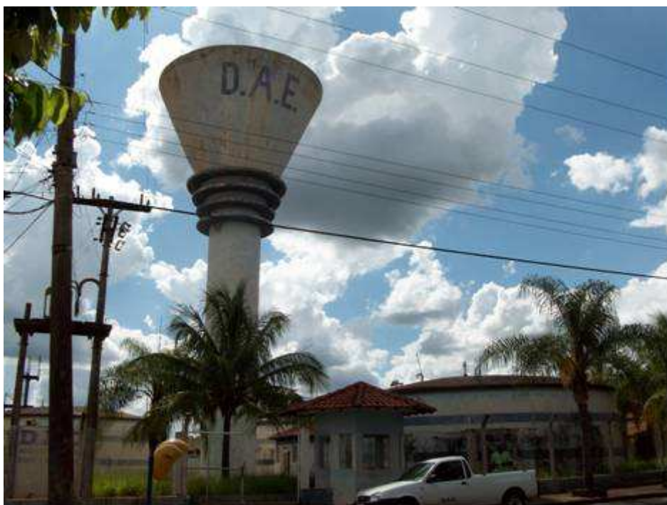
Ilustração 5.34 - Vista geral do CR Caixa Torre com destaque para o reservatório elevado (Caixa Torre)
