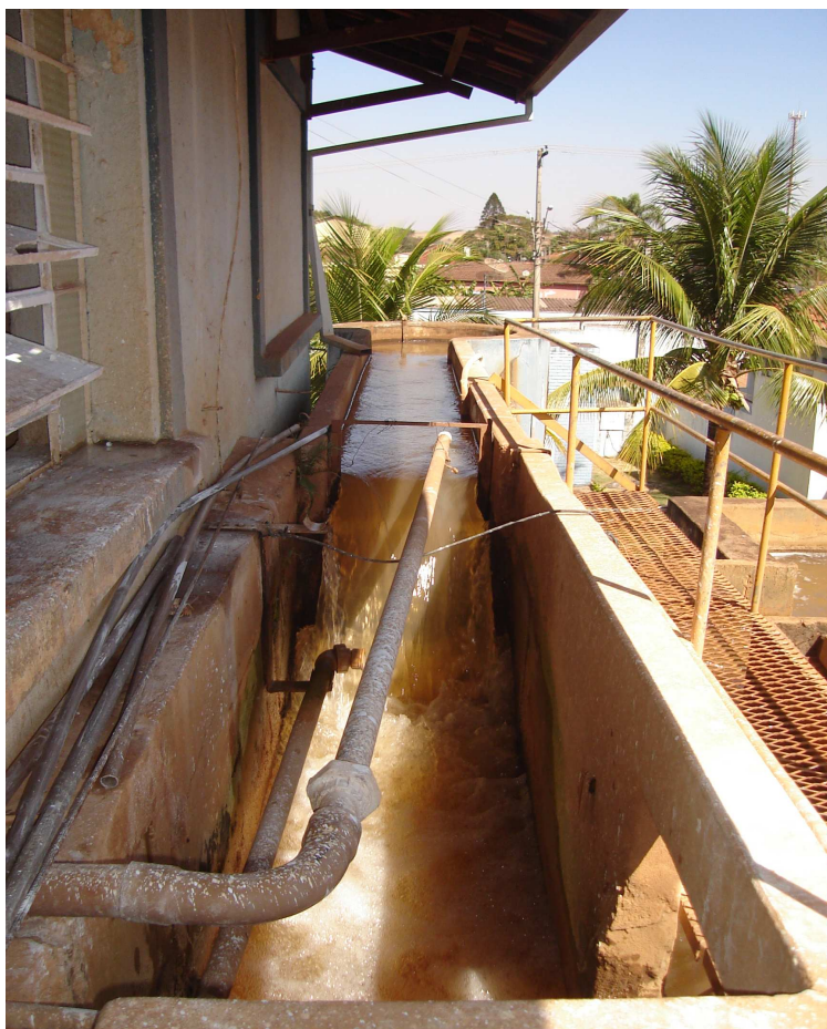
Ilustração 5.11 - Canal de chegada de água com aplicação de cal hidratada em sua porção inicial e sulfato de alumínio imediatamente a montante do vertedor
