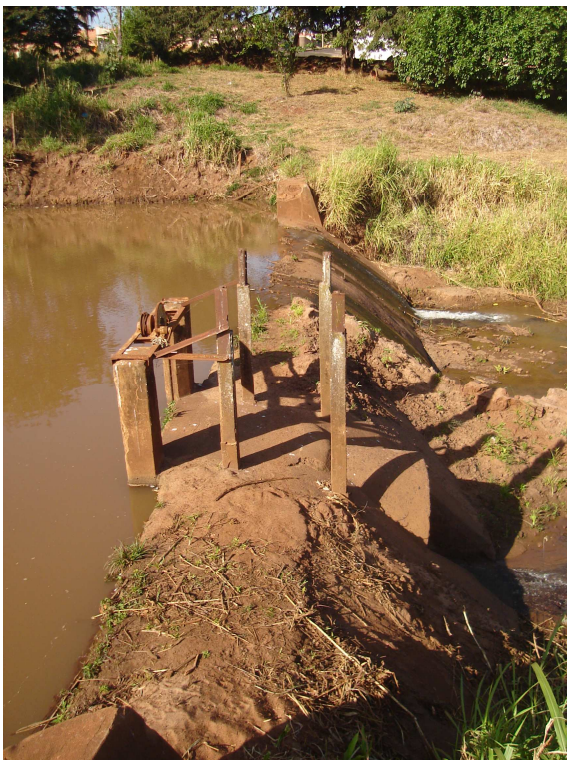
Ilustração 5.1 - Barragem de nível no córrego do Palmito
