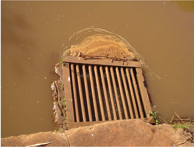
Ilustração 5.2 - Estrutura de captação com grade grosseira
