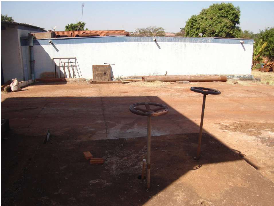
Ilustração 5.32 - Vista do reservatório semi-enterrado do CR ETA (poço de sucção da EEAT)
