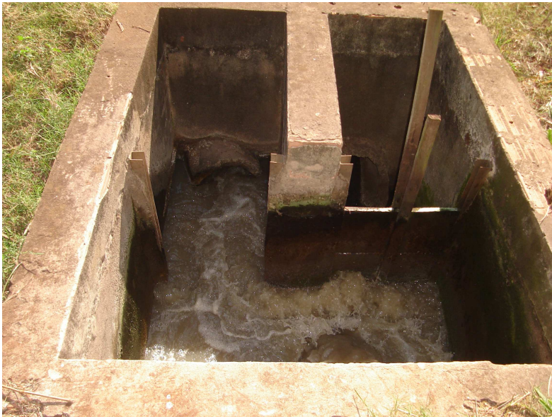
Ilustração 5.41 - Caixa divisora de fluxo para os dois módulos de tratamento
